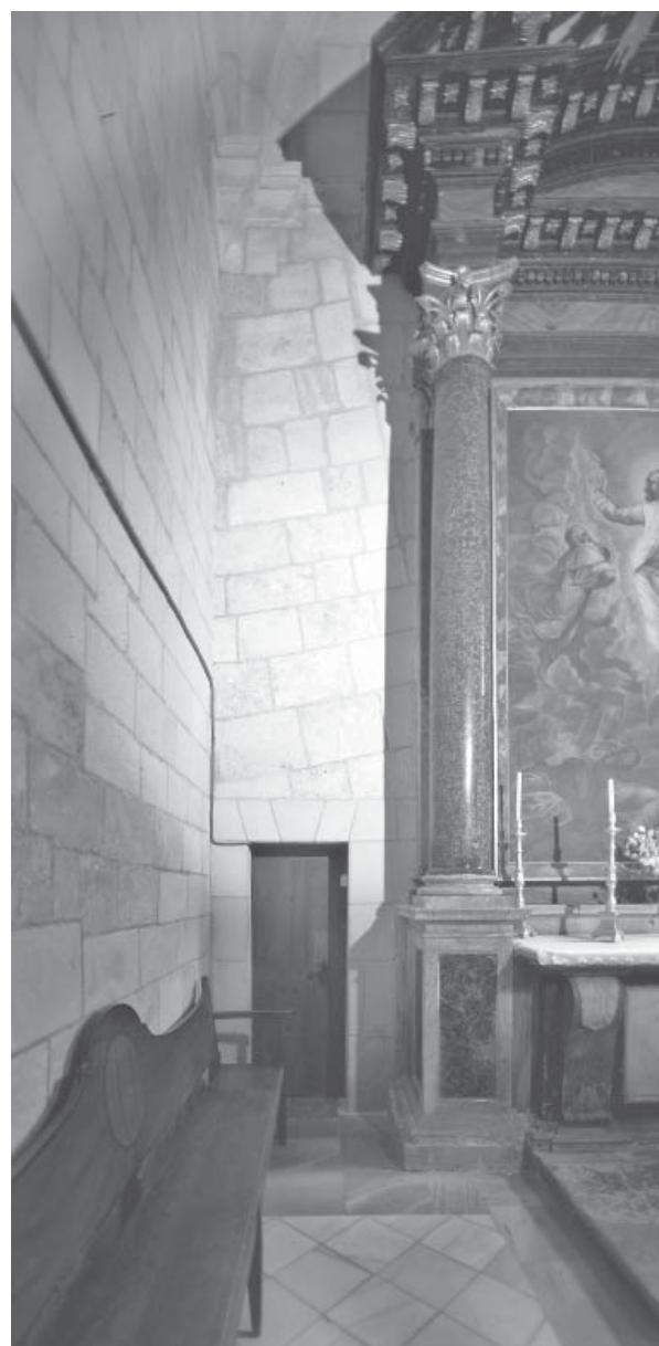
16.3. Antiguo contrafuerte en la capilla de la Transfiguración.
