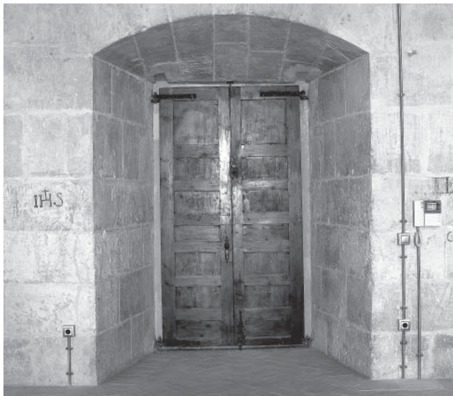
9.26. Capialzado en el hueco de acceso a la estancia del segundo cuerpo de la torre.
