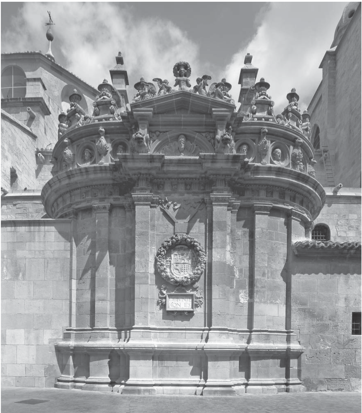
12.8. Exterior de la capilla de Junterón.
