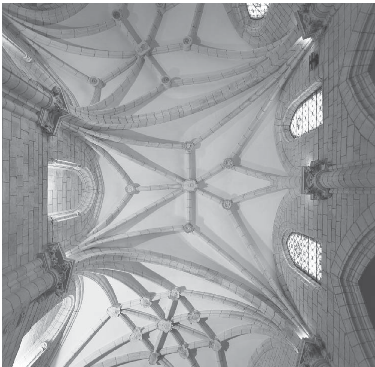
14. 4. Bóveda nervada frente a la Puerta del Pozo.
