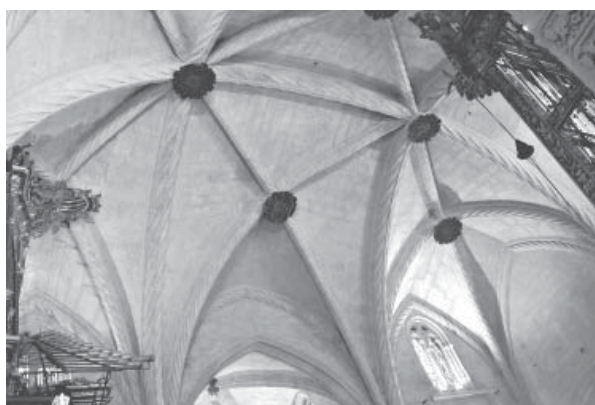
3.1. Bóvedas en el crucero de la catedral de Orihuela.
