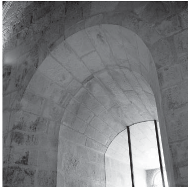
9.28. Detalle del capialzado en el trasdós de la bífora que ilumina el segundo cuerpo de la torre.
