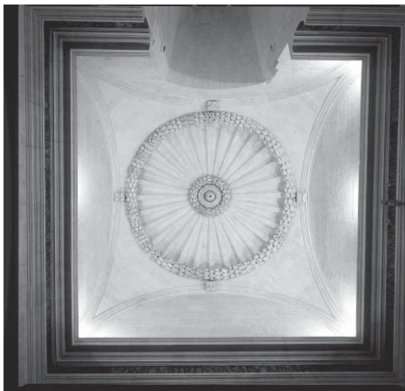
7.1. Bóveda de la sacristía.
