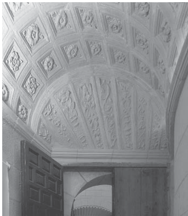
9.8. Capialzado esviado en el trasdós de la portada jónica de la antesacristía.
