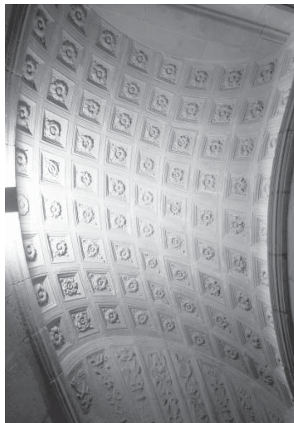
8.1. Bóveda del paso entre sacristía y antesacristía.
