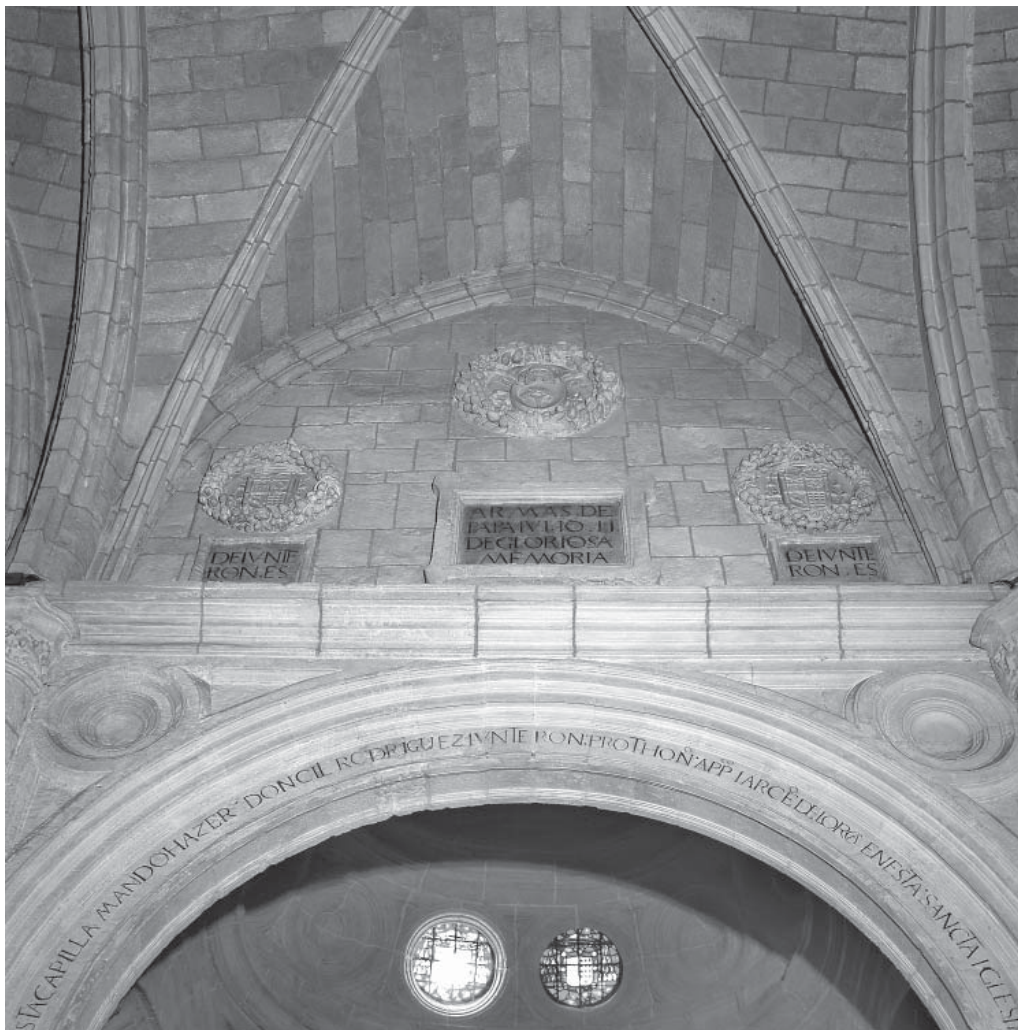
11.3. Arco de acceso a la capilla de Junterón desde la nave lateral de la catedral.
