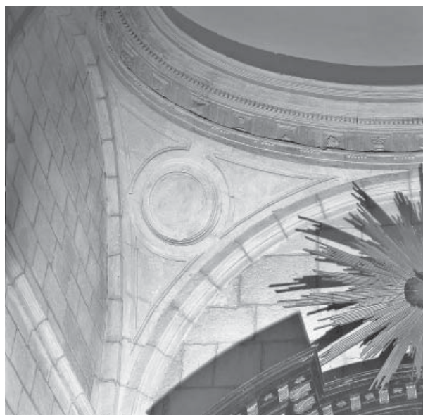
16.2. Pechina en la capilla de la Transfiguración.
