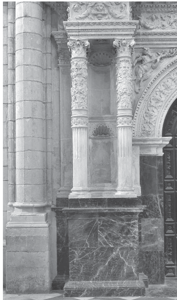
9.2. Pedestales y columnas de la portada en arco de triunfo.
