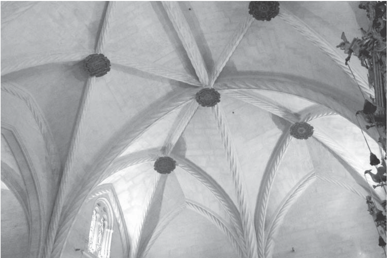
19.6. Arcos torsos en el crucero de la catedral de Orihuela.
