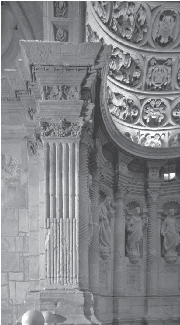
12.2. Pilastra bajo el arco de acceso a la recapilla de Junterón.
