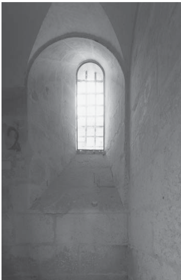
9.24. Capialzado de dos arcos en las rampas de la torre.
