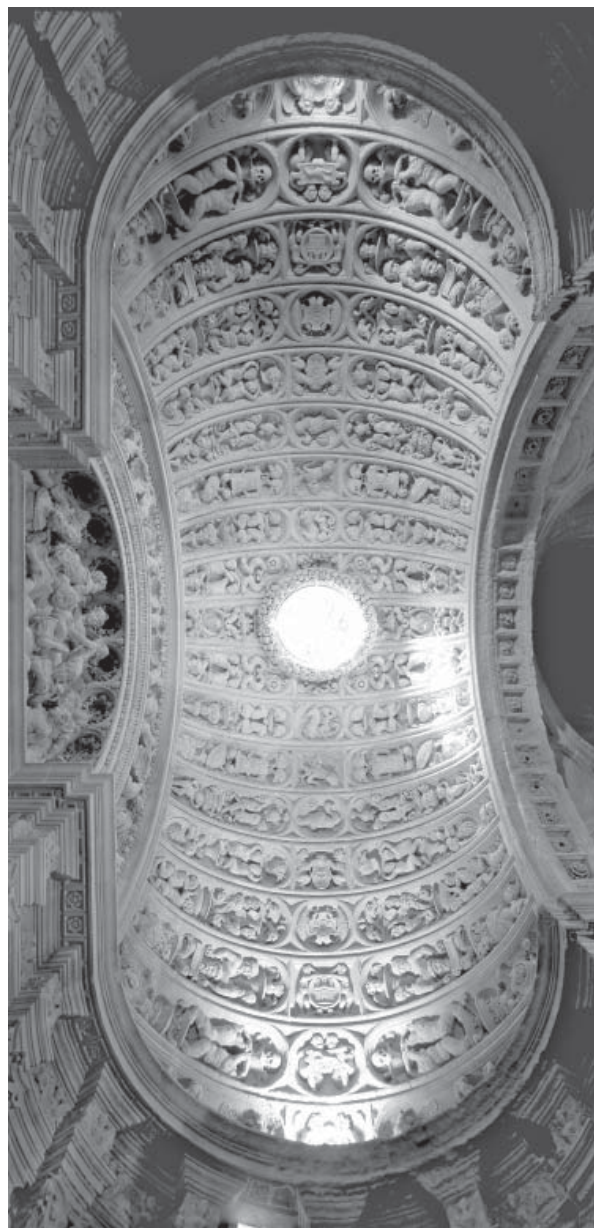
12.13. Bóveda tórica en la recapilla de Junterón.
