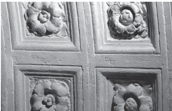
8.2. Detalle de la bóveda del paso entre sacristía y antesacristía con marcas de cantero.
