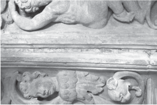
12.26. Juntas entre dovelas en la bóveda de la recapilla de Junterón.
