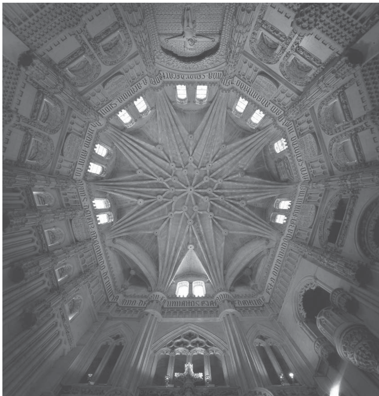
19.10. Bóveda de la capilla de los Vélez.
