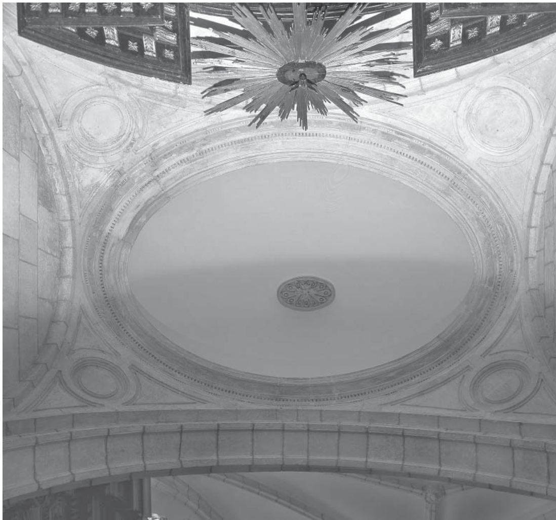
16.1. Bóveda de la capilla de la Transfiguración.
