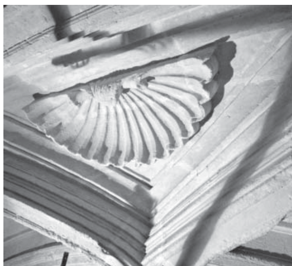
15.7. Segundo plemento de la bóveda del segundo cuerpo de la torre, desde el andamio dispuesto para su limpieza en 2003.
