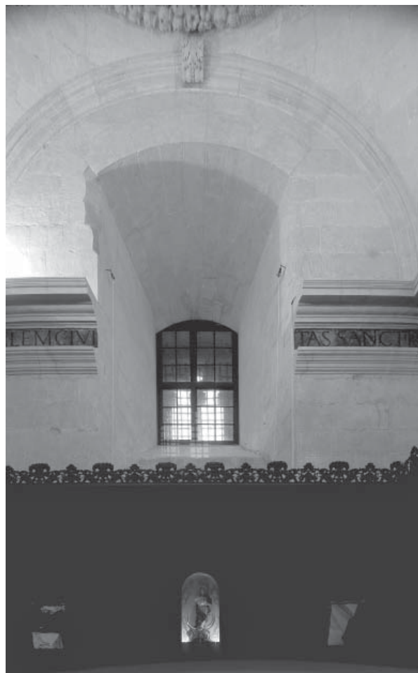
9.20. Capialzado en el trasdós de la bifora que ilumina la sacristía.
