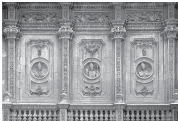
6.9. Pilastras y paneles en el segundo cuerpo de la Puerta de las Cadenas.
