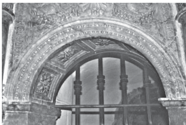
19. 5. Arco esviado monolítico en la capilla de la Resurrección de la catedral de Valencia.
