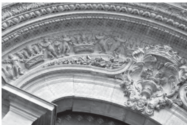
6.5. Arco carpanel de refuerzo de la Puerta de las Cadenas.
