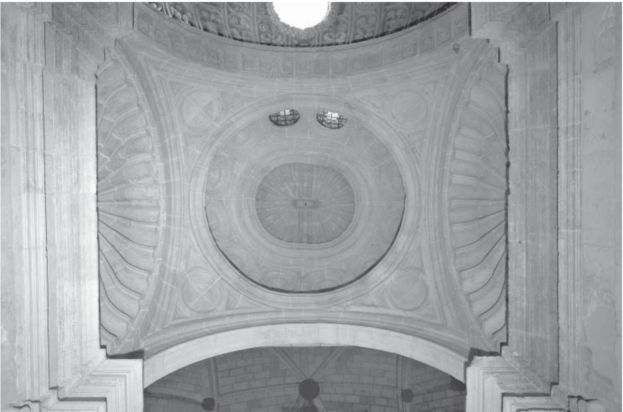
11.7. Bóvedas de la antecapilla de Junterón.
