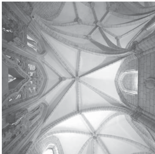
14.21. Bóveda de crucería frente a la capilla de los Vélez.
