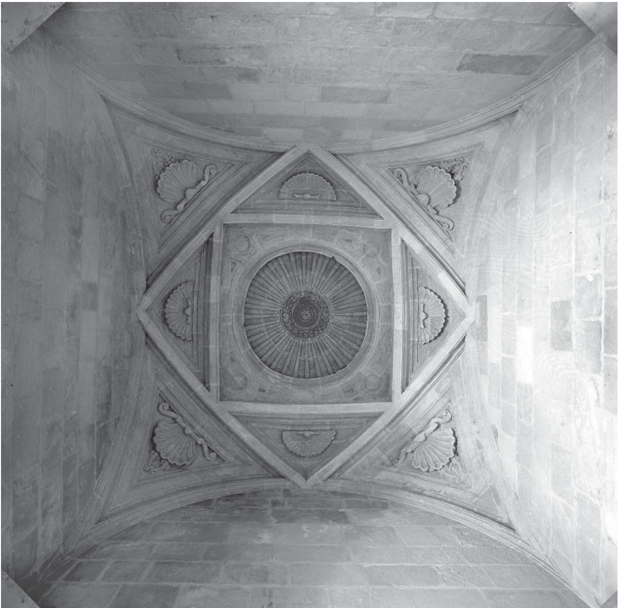
15.1. Bóveda de la estancia del segundo cuerpo de la torre.
