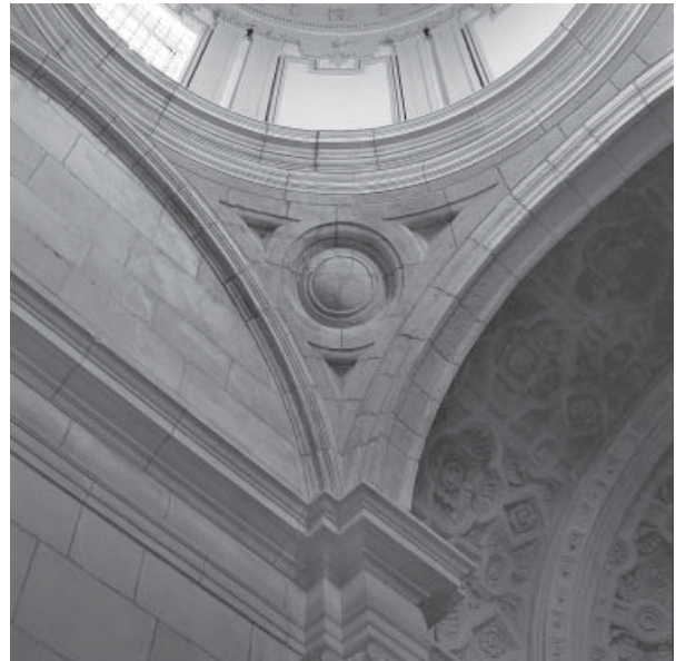
17.2. Pechina bajo la bóveda de la capilla del canónigo Grasso.
