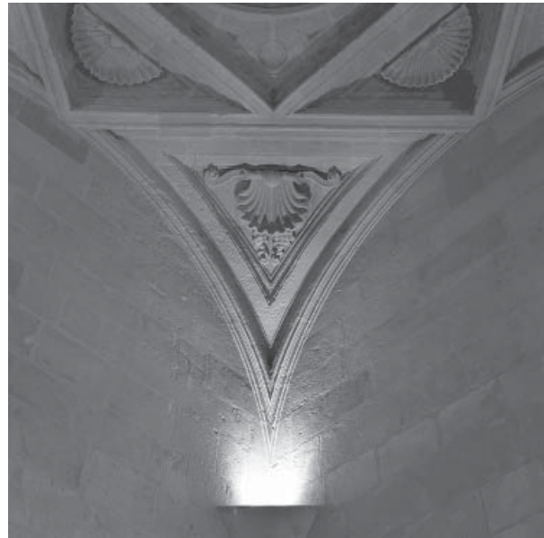
15.6. Primer plemento de la bóveda de la estancia del segundo cuerpo de la torre.
