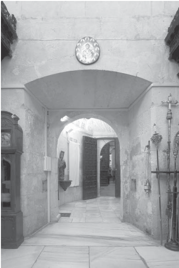
9.10. Capialzado desquijado en el trasdós del arco florentino.
