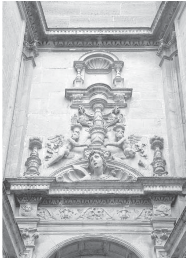
18.1. Exterior de la cabecera de Santa María de Chinchilla.
