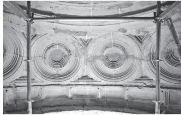
11.10. Óculos y friso de la bóveda de la antecapilla de Junterón, desde el andamio dispuesto para su limpieza en 2003.
