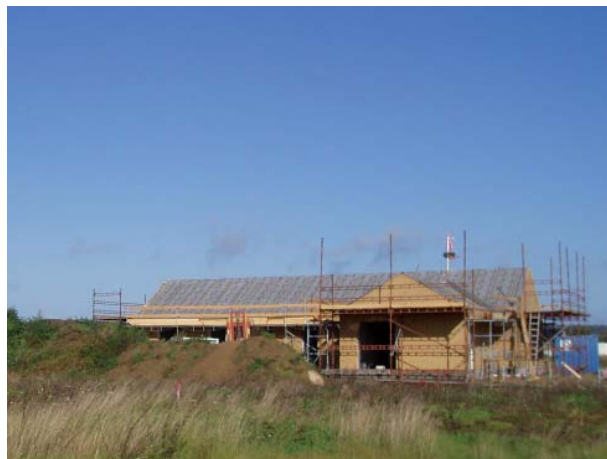
Parcelhus der er ved at blive bygget.
