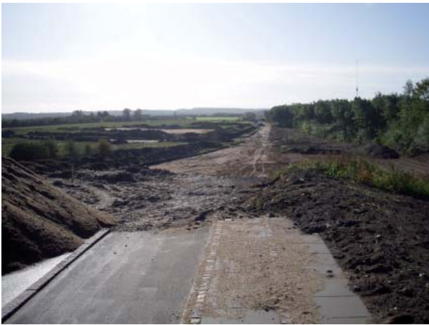
Stamvej under etablering i udstykningsområde i Støvring.
