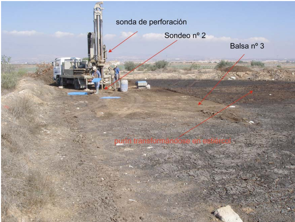
Foto 6. 45. Vista de la posición del sondeo mecánico n° 2 en la balsa n° 3.
