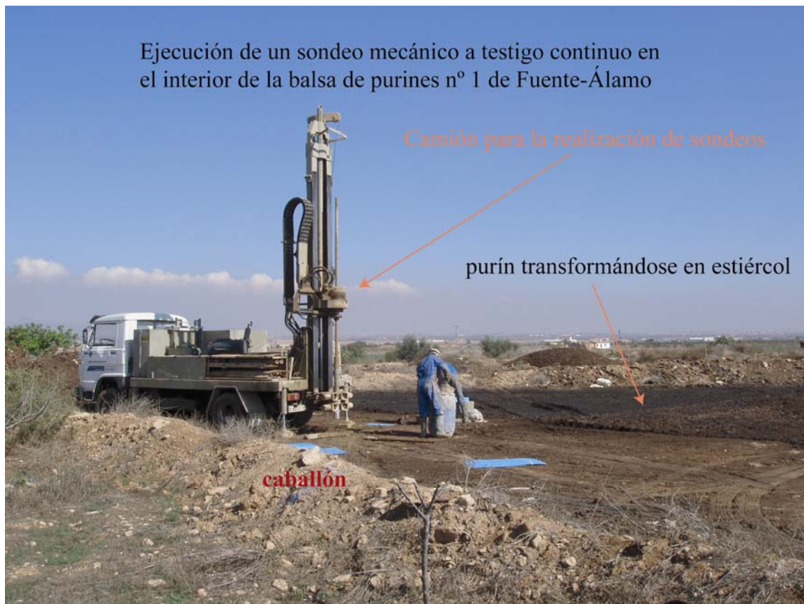
Foto 2. 7. Sondeo mecánico con testigo continuo en una de las balsas de purines.
