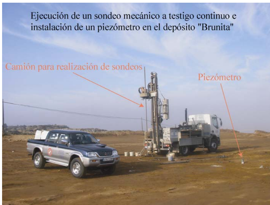
Foto 2. 3. Sondeo mecánico con testigo continuo en el depósito "Brunita".
