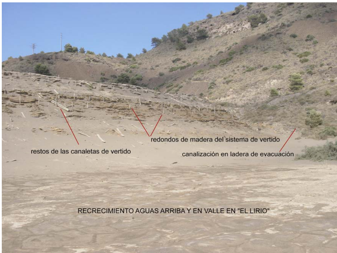
Foto 5. 1. Dique recrecido "aguas arriba" y restos del sistema de vertido con canaletas de madera en el depósito "El Lirio".
