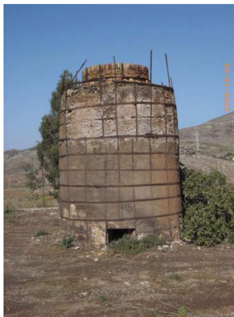
Foto 2.33. Horno de Fundición. Estrecho de San Ginés. Junio 2004.
