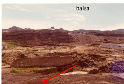
Foto 8.16. Rotura de la balsa “Brunita” (Foto IGME, 1974b)
