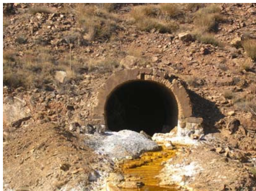
Foto 6.7. Galería de mina. Túnel Lilian, en la corta Gloria.
