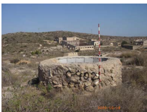
Foto 4.3. Protección de mampostería.
