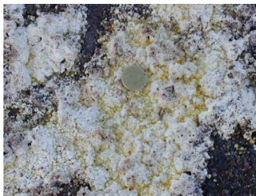
Foto 9.4. Detalle de sales precipitadas sobre los residuos mineros. Balsa de lodos La Esperanza.
