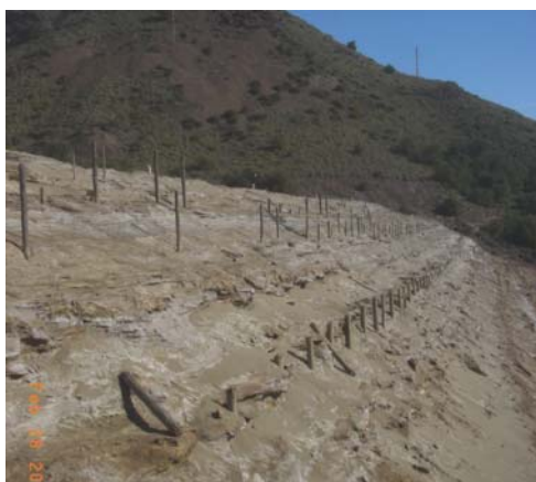
Foto 5.6. Sistema constructivo de las balsas de lodos. Colocación de troncos para conseguir más altura. Balsa de la mina Santa Antonieta.
