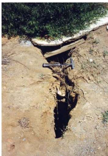
Foto 8.8. Grieta nº 38 localizada frente a las Casas de la mina La Cierva. Obsérvese la amplitud de la misma en relación con el martillo.
