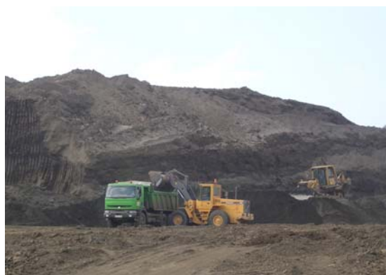
Foto 2.28. Carga auxiliada por bulldozer.
