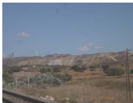
Foto 5.2. Vacies de la corta Brunita. Carretera de La Unión a Portman.
