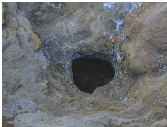
Foto 7.19. Troncos de madera podridos en el talud de la balsa que servían de dique para mantener el lodo.
