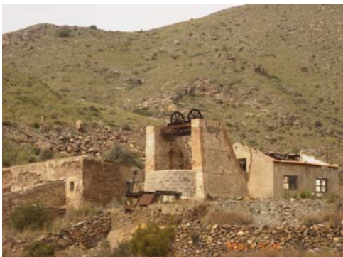
Foto 4.11. Castillete de mampostería. Concesión minera ‘San Guillermo’.
