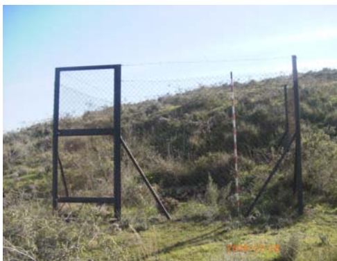
Foto 4.6. Protección de alambrada.
