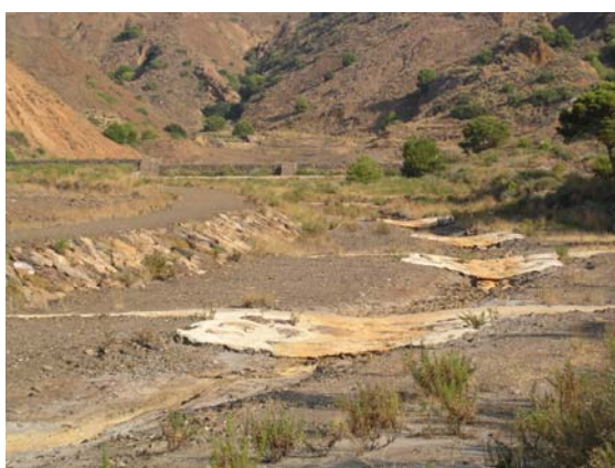
Foto 7.4. Obras de encauzamiento en la rambla de Portman.
