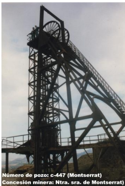
Foto 4.13. Castillete de hierro de la mina Montserrat. Cabezo Rajao.
