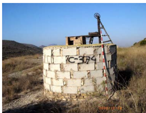
Foto 4.2. Protección de bloques.
