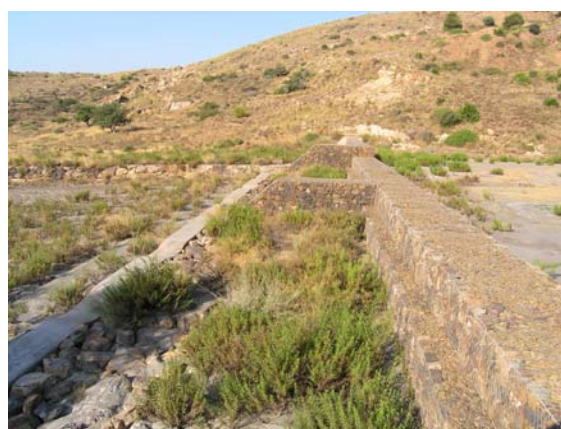
Foto 7.5. Detalle de los gaviones de la rambla de Portman.
