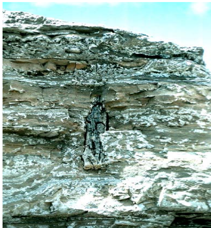
Foto 7.19. Troncos de madera podridos en el talud de la balsa que servían de dique para mantener el lodo.
