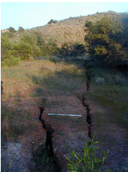
Foto 8.14. Grietas sobre el pantano.
