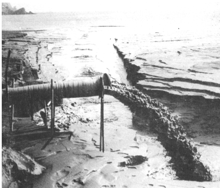
Foto 7.13. Tubería del vertido de lodos, procedentes del proceso de flotación diferencial, a 400 m al Oeste de Punta Galera (González y Baños, 1987).
