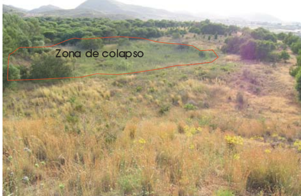
Figura 8.12. Colapso producido en la balsa de lodos “Marqués de Pejas”.
