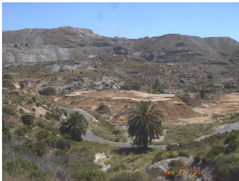
Foto 5.8. Balsa de lodos de flotación. Emplazamiento en exenta. Mina San Francisco Javier, carretera del Gorguel.
