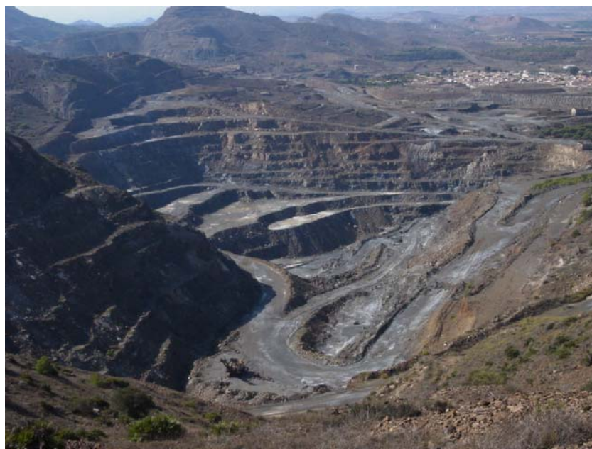
Foto 2.26. Corta Sultana . Oeste de la sierra de Cartagena-La Unión. (área: 0,306 km 2 , ejes: 500x800 m, profundidad: 200 m). Junio 2004.
