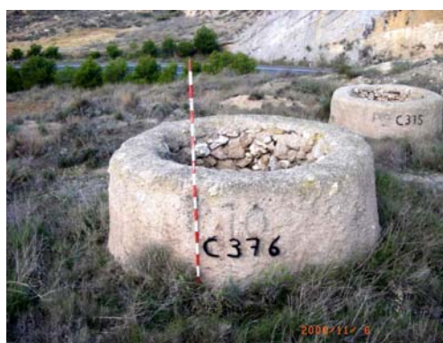
Foto 4.4. Protección de bloques-mampostería.
