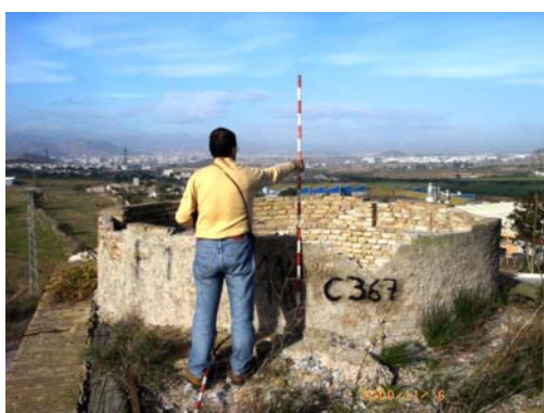
Foto 4.1. Protección de ladrillo.
