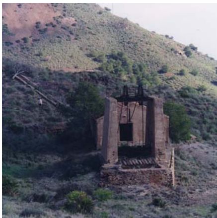
Foto 2.19. Castillete y casa de máquinas del pozo de extracción de la mina San Ignacio, en materiales del mioceno, en la sierra de Ponce (Llano del Beal).
