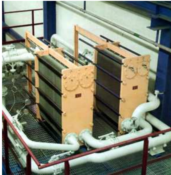
Fig. N° 10. Dos equipos funcionando en paralelo como recuperadores de calor.
