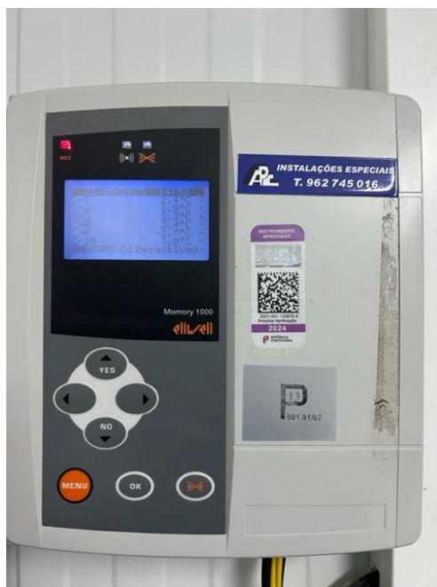
Figura 7: Equipamento de registo e recolha de dados de temperatura da fábrica (Memory 1000 Eliwell) (Fonte: Elaborado pelo autor)
