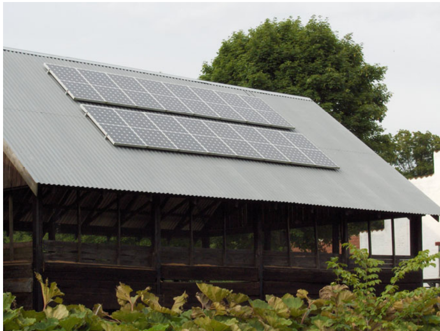
Figur 13. Afgørende for et solcelleanlægs ydeevne, er ikke om der er et forbrug i det hus, det placeres på, men derimod tagfladens orientering på det pågældende hus (foto Ellehaug).
