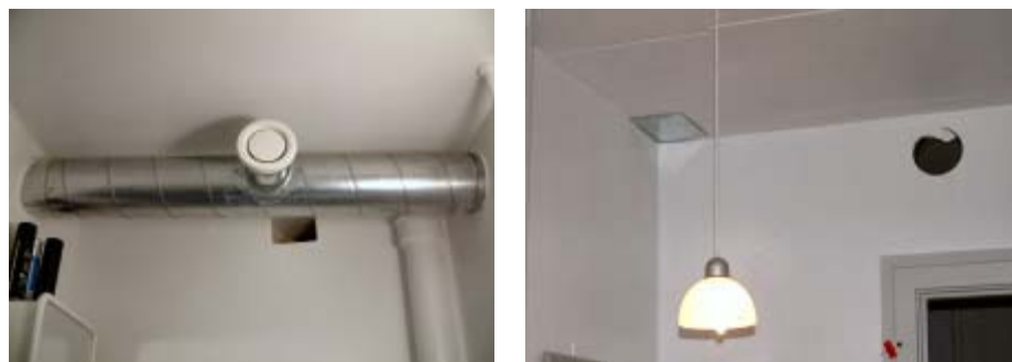
Figur 30. Eksempler på ufuldstændige installationer. Til venstre wc- og baderum i en Uds-lejlighed hvor den eksisterende aftrækskanal ikke er blændet. Til højre et køkken hvor den eksisterende aftrækskanal er blændet, mens der endnu kun er boret hul i væggen over døren til kanalen for den mekaniske udsugning.
