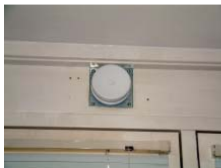
Figur 8. Fugtstyret udeluftventil fabr. Aereco type EHT 5-40. Ventilens udvendige mål er ca. 14 x 24 cm.
