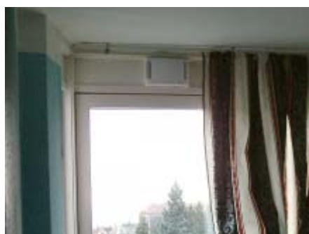
Figur 32. Eksempler på ideel placering af udeluftventiler (de øverste fire fotos) og mindre ideel placering (de nederste fire fotos).
