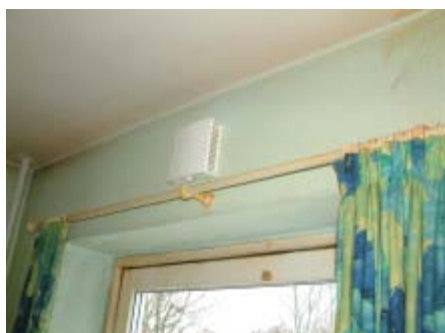
Figur 9. Standard udeluftventiler.
