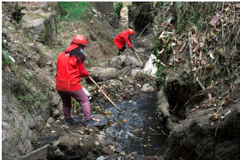
Foto 32.- Limpieza de Quebrada – Generación de puestas de trabajo – C.P. Cachicadán.
