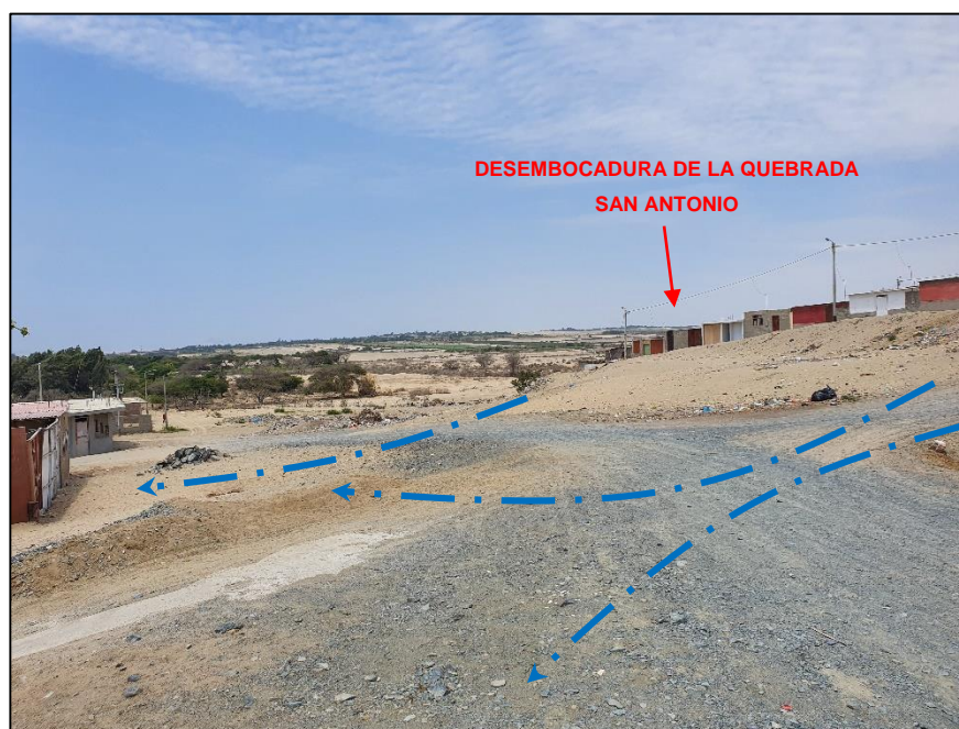
Foto N°03. Vista panorámica de la desembocadura de la quebrada San Antonio – Entre A.H Bellos Sur y Urb. Garatea – Nuevo Chimbote.
