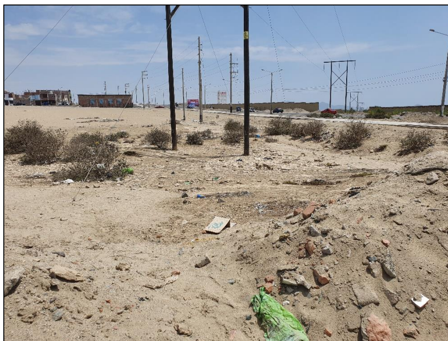
Foto N°11. Vista de la acumulación de residuos, en la Av. Central – Nuevo Chimbote, a causa de la intensa precipitación ocurrida en Marzo del 2017.
