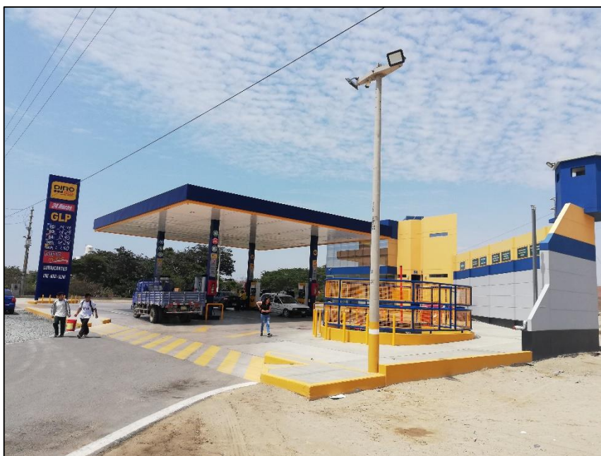
Foto N°08. Grifo la Central, ubicado en la Av. Central – Nuevo Chimbote, el cual tuvo daños materiales, durante la fuerte precipitación del 14 de marzo del 2017.
