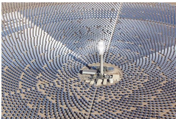
Сл. 2.14. Хелиостатско поље са равним огледалима (Helioscsp 2015) Fig. 2.14. Heliostatic field with flat mirrors (Helioscsp 2015)
