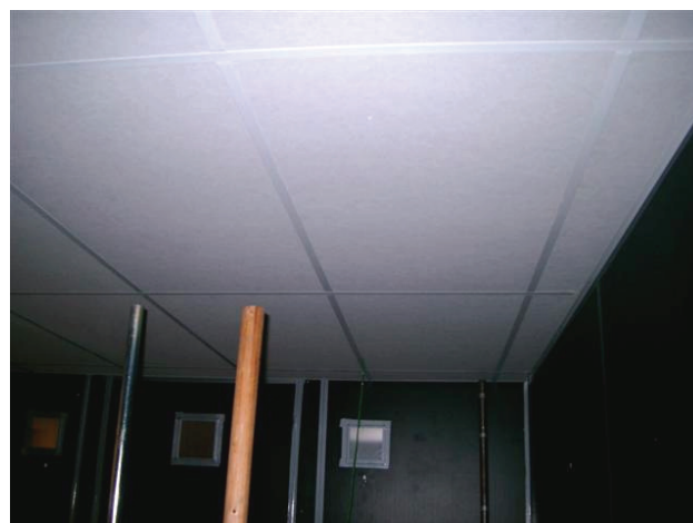
Figur 4. Loft med diffus ventilation.
