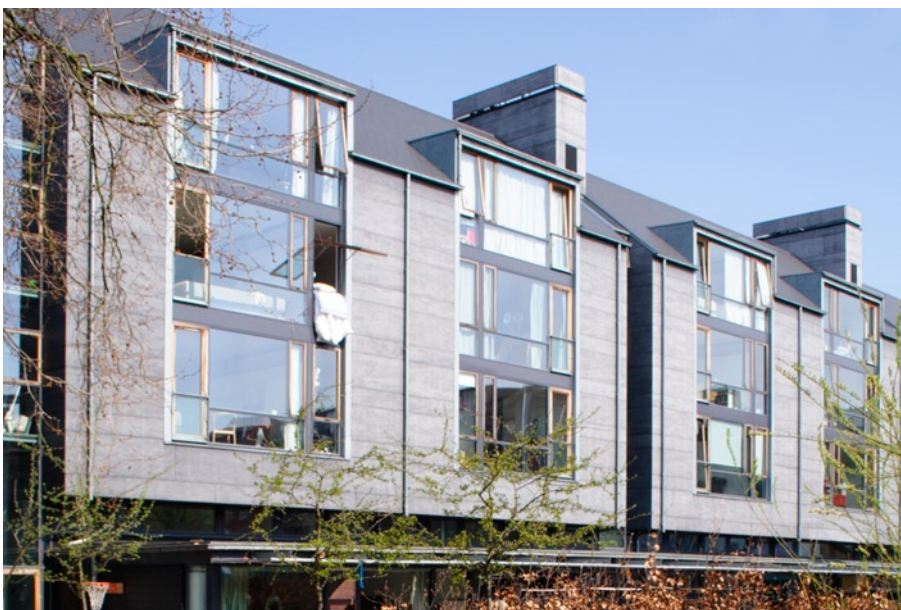
Etagehus med zonedelte planløsning og decentrale installationsføring Prinsessegade, Christianshavn, 2000
