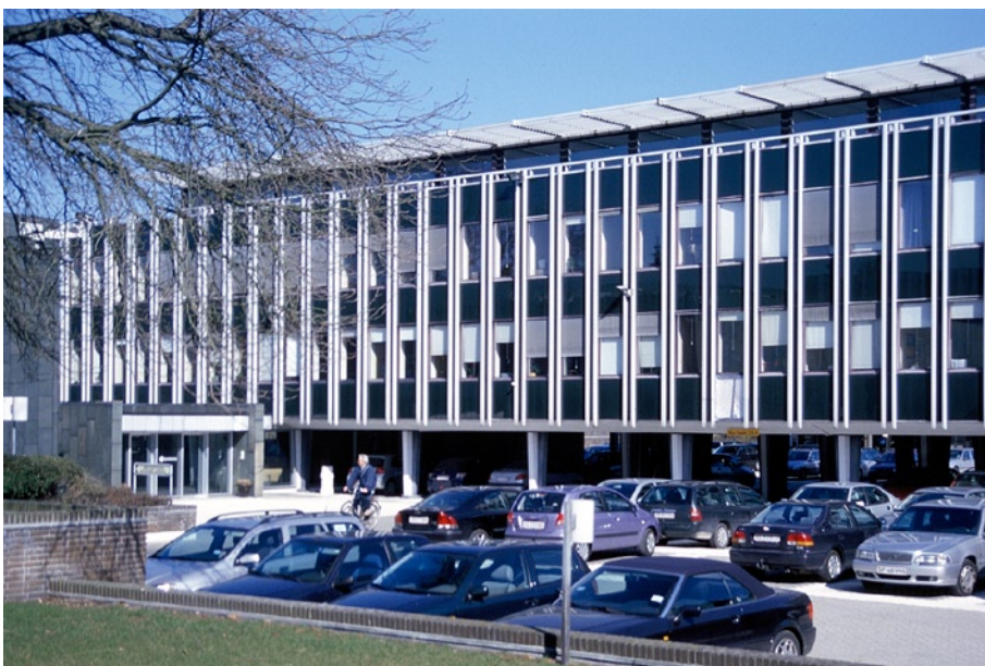
1970'erne: Det demokratiske kontor med funktionsopdeling langs bygningens midterakse WHO's regionalkontor for Europa, København Arkitekt: Svend Eske Kristensen Ingeniør: Schøning, Kjeldsen & Støttrup Opførelse: 1972
