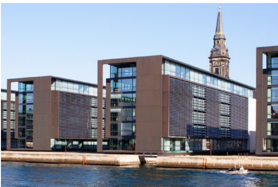
1990'erne: Det intelligente kontor med decentralisering af bygningens servicezoner Unibank, Christianshavn Arkitekt: Henning Larsens Tegnstue Ingeniør: Cowiconsult Opførelse: 1998 -2001
