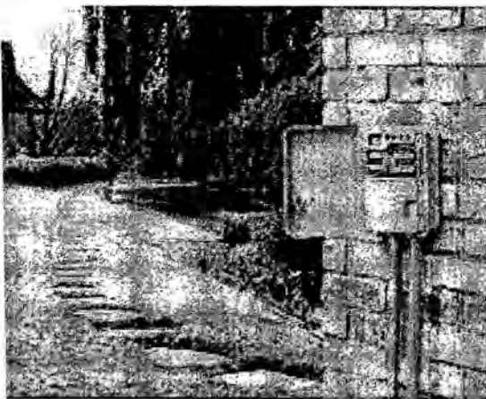
El programador automático guarda información acerca de cuales días y a que hora debe iniciarse el riego y durante cuanto tiempo regará en cada zona.
