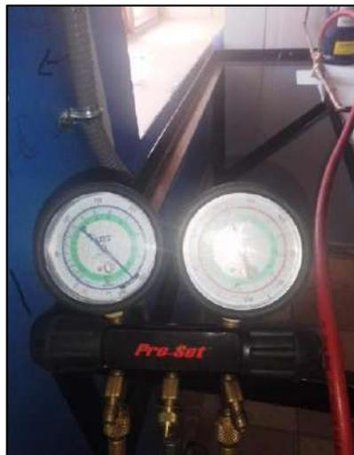
7. **Deshidratación del sistema:** Realización de vacío en líneas de refrigeración (hasta los 500 micrones –medidos con vacuómetro) antes de romper el vacío para la carga del gas refrigerante. Carga de gas refrigerante R-404<sup>a</sup> (Ecológico).
