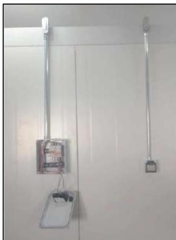
**Figura 3.26.** Instalación de luminarias interiores
