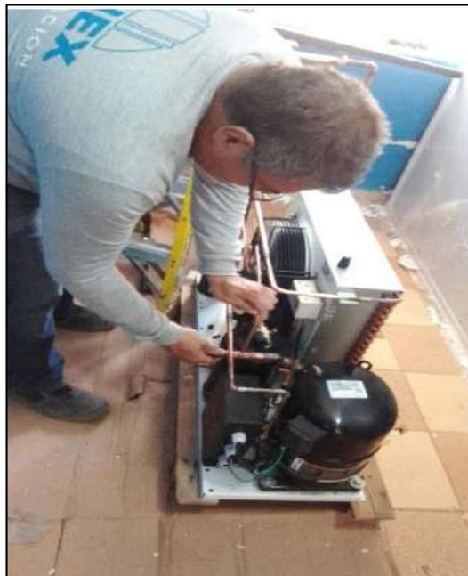
**Figura 3.24.** Instalación de unidad condensadora
