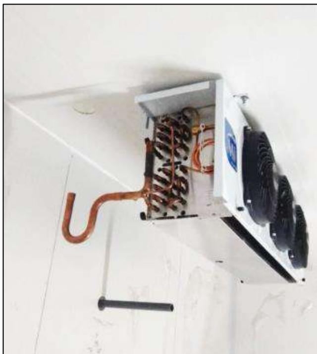
**Figura 3.22.** Soldadura de tubería de succión y líquido al evaporador
