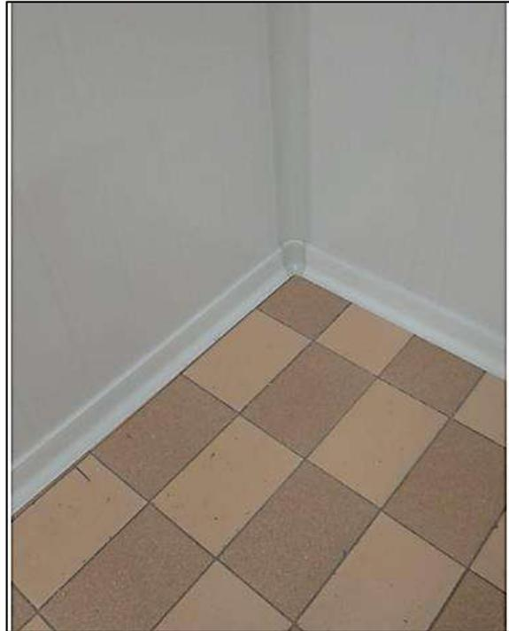
**Figura 3.20.** Instalación de perfiles sanitarios exteriores
