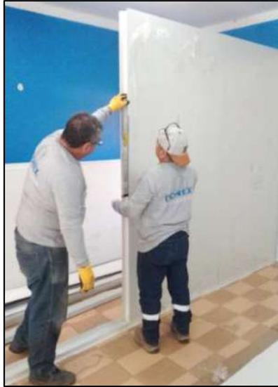
**Figura 3.13.** Instalación Panel termoaislante
