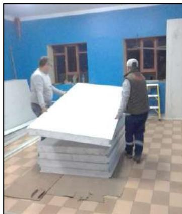
Posteriormente se colocó cada panel en forma vertical (pared) sobre los canales U debidamente nivelados.
