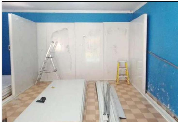
Para la unión de estos paneles verticales se realizó con el sistema de ensamble tipo machihembrado, y para darle un mejor ajuste se presionó con remaches de medida  $5/32 \times \frac{1}{2}$ .
