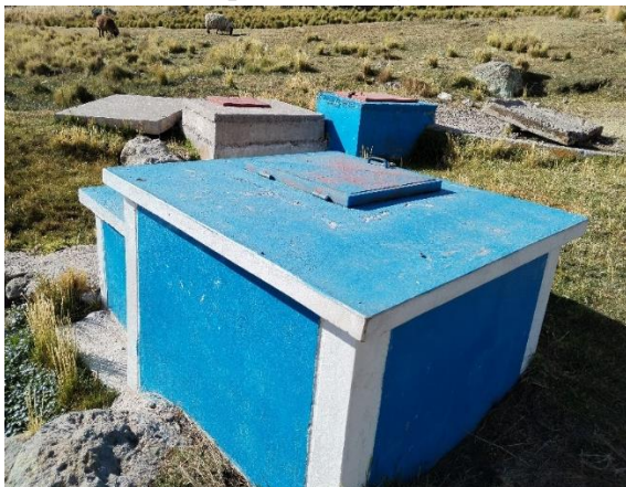
Captación de agua
