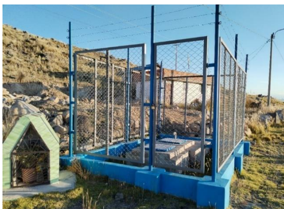
Captación de agua
