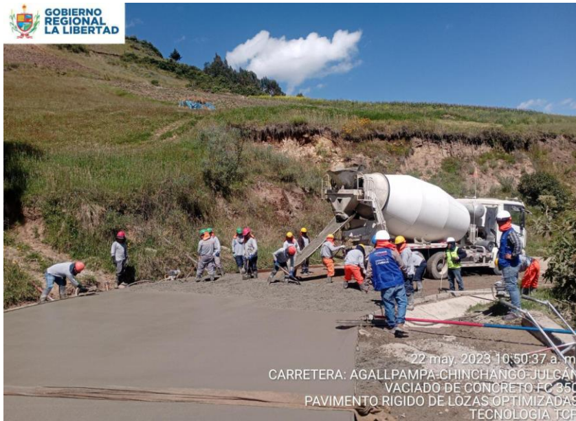
Fotografía N° 03: Vaciado de concreto
