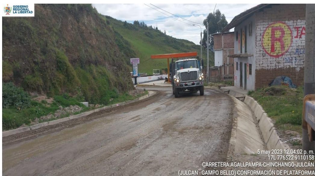
Fotografía N° 14: Riego de base
