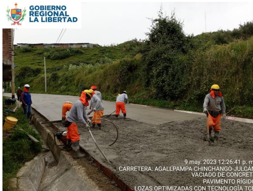
Fotografía N° 12: Vibrado de concreto
