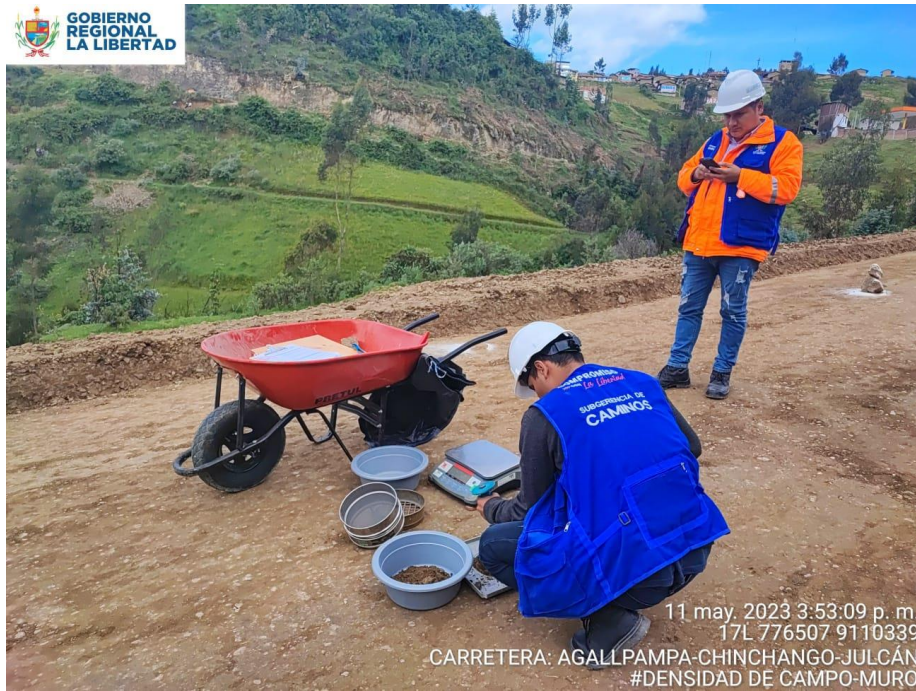
Fotografía N° 09: Ensayos de densidad de campo a la base granular
