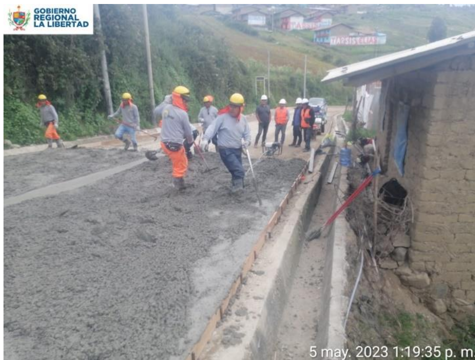
Fotografía N° 16: Vibrado de concreto
