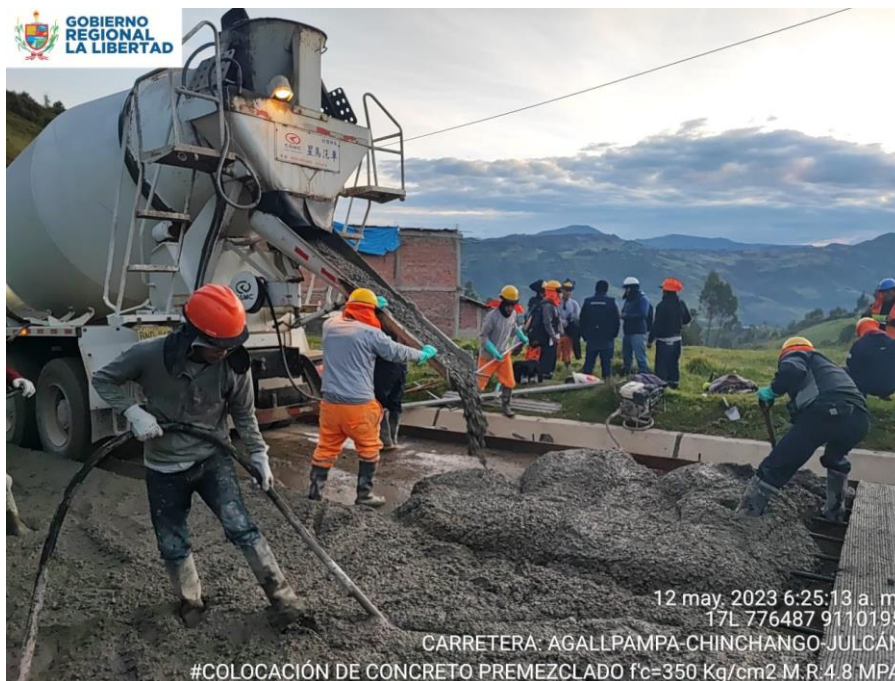
Fotografía N° 08: Suministro y vibrado de concreto
