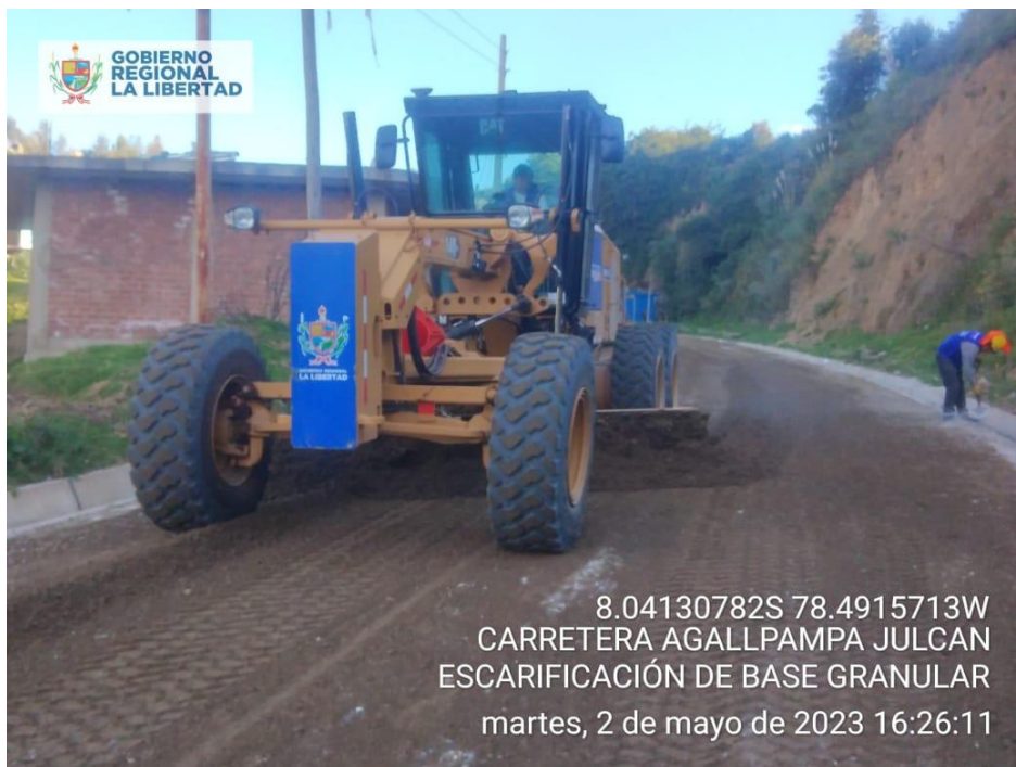
Fotografía N° 18: Conformación y nivelación de base
