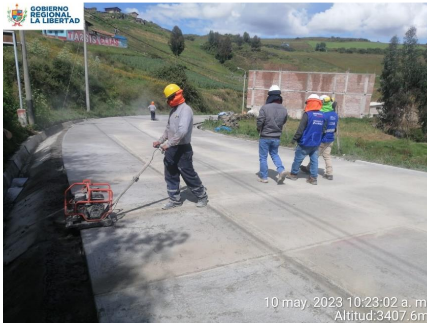
Fotografía N° 11: Corte de 3mm en pavimento
