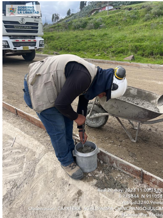
Fotografía N° 05: Ensayos correspondiente al concreto
