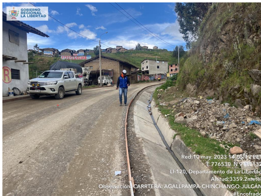
Fotografía N° 10: Verificación de alineamiento del encofrado
