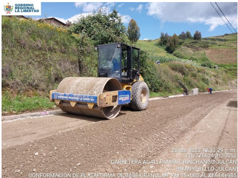
Fotografía N° 19: Compactación de base
