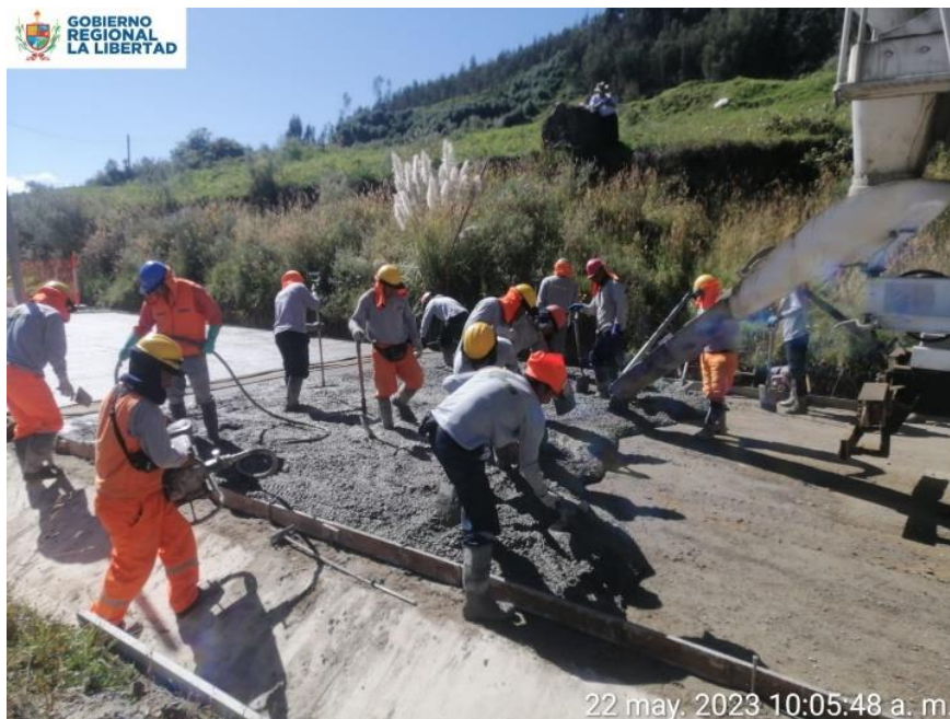
Fotografía N° 04: Suministro y vibrado de concreto
