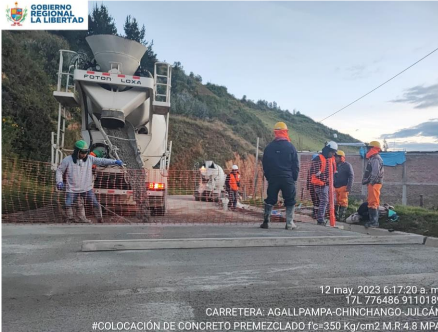
Fotografía N° 07: Suministro de concreto
