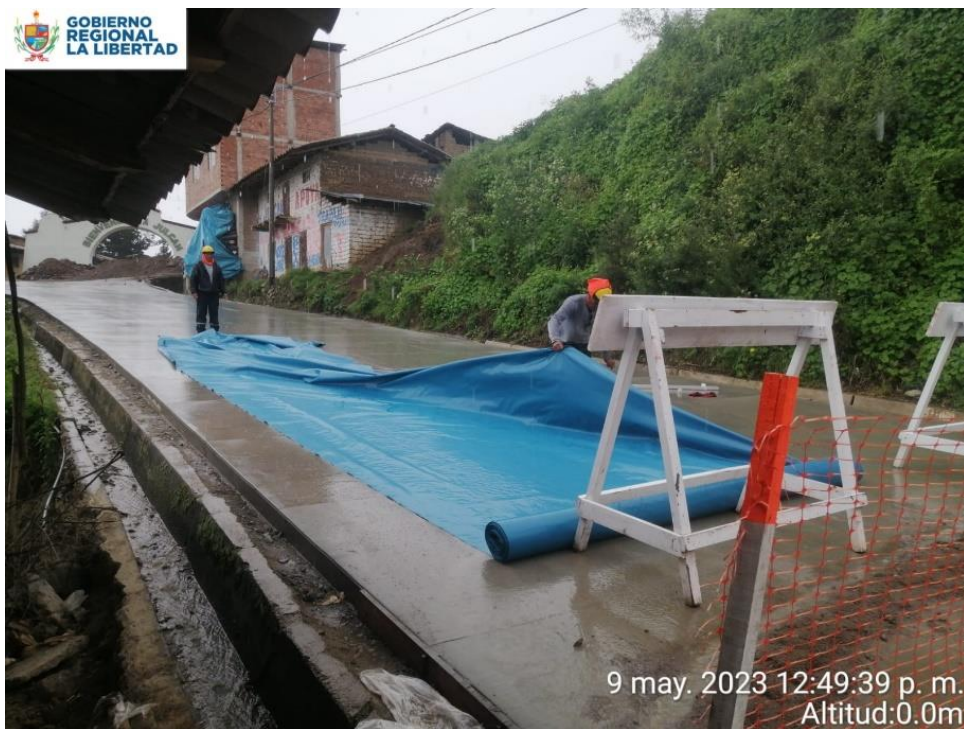
Fotografía N° 13: Vibrado de concreto
