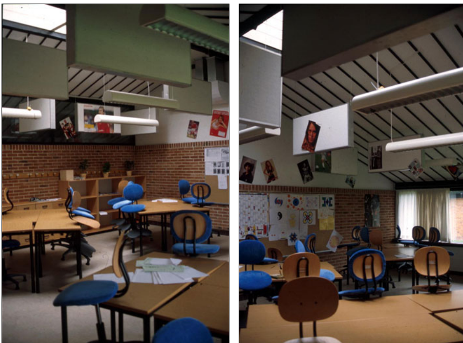
Figur 37. Solvang skole. Klasselokale, kig mod bagvæg og ovenlys (t.v.) og kig mod vindues- og endevæg (t.h.). Kontrasten fra de mørkere gange til de lyse undervisningslokaler er ikke generende, fordi de højtstående vinduer ikke ses i modlys, når man træder ind.
