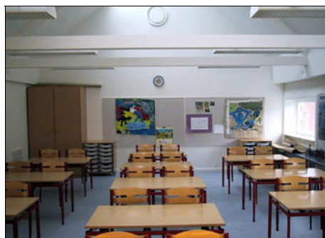
Figur 22. Rådmandgades skole. Klasselokalerne modtager rigeligt dagslys, især fra de skrå tagvinduer. Lyse farver overalt bevirker at lysfordelingen opleves behagelig. Tagvinduerne sidder så højt, at blændingsproblemer vil optræde ret sjældent, men en afskærmning er dog nødvendig.
