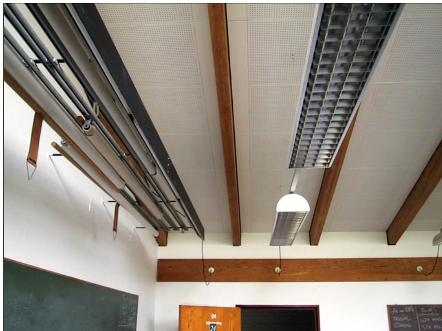
Figur 70. Lyskasse for den gamle tavlebelysning.
