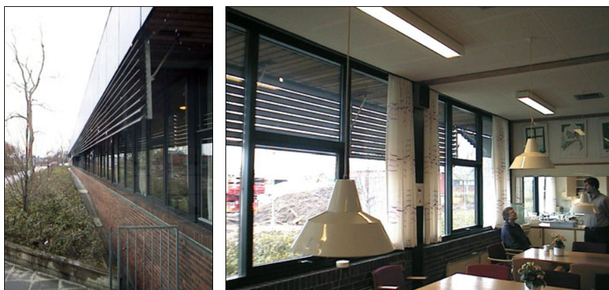
Figur 41. Hedegaardsskolen, gamle del. Afskærmningen består af lodrette lameller, som er drejelige, men i praksis giver afskærmningen altid en kraftig reduktion af lysindfaldet.
