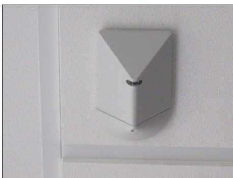
Figur 82. Dagslysføler på loftet i referencelokalerne.
