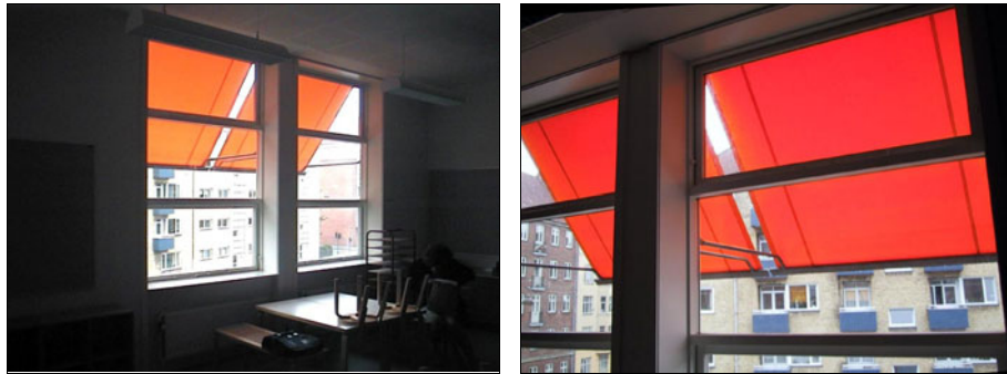
Figur 43. Rådmandsgade skole. På nogle af de gamle skoler i København anvendes markiser som solafskærmning. Løsningen er relativt billig og god, sammenlignet med andre udvendige løsninger. Markiser kan dog ikke anvendes, når det blæser kraftigt, og i visse tilfælde kan det være et problem, at de tillader direkte sollys at passere i de åbne trekanten og i mellemrummet mellem to markiser.
