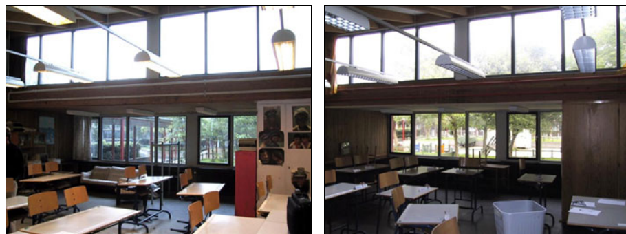
Figur 25. Tingbjerg skole. Den lavere del får dagslys fra et gennemgående vinduesbånd med udsigt til skolegården, mens det største areal hovedsageligt får dagslys fra et stort, højsiddende vinduesparti, placeret over nichen.
