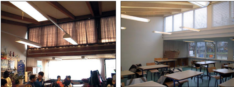
Figur 27. Tingbjerg skole. De høje vinduer giver ofte generende blænding, og er derfor i de fleste lokaler forsynet med gardiner. Gardiner er flere steder permanent trukket for, så dagslyset i rummet slet ikke bliver som tilsigtet. I de to renoverede lokaler er opsat persienser, som nemt kan justeres efter behovet.
