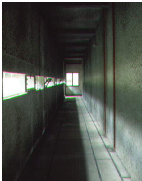
Figur 6. Eksempel på aftegning af himmelgrænseplanet, som her ses tydeligt aftegnet på gulv og nederste del af væg i gangen på Le Corbusiers kloster La Tourette, nær Lyon i Frankrig.
