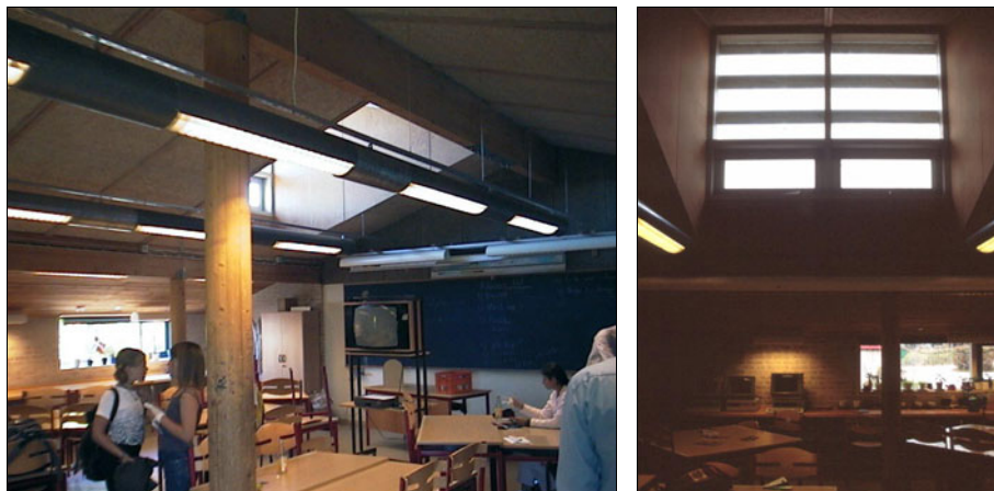
Figur 30. De forholdsvis mørke overfladerne i klasselokalerne på Stenvad skole medvirker til, at lysfordelingen bliver meget uensartet. Trælammellerne i kvistvinduerne burde være lysere og drejelige, og farverne på væg- og loftsflader lysere.
