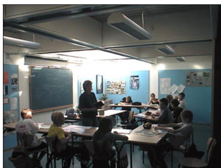
Figur 17. Stavnsholt skole. Efter ombygning er ovenlys placeret meget uhensigtsmæssigt i forhold til rummet, og dagslysforholdene er utilfredsstillende. Nogle elever opholder sig i lodret 'spotlys', mens andre sidder i et relativt alt for mørkt område.
