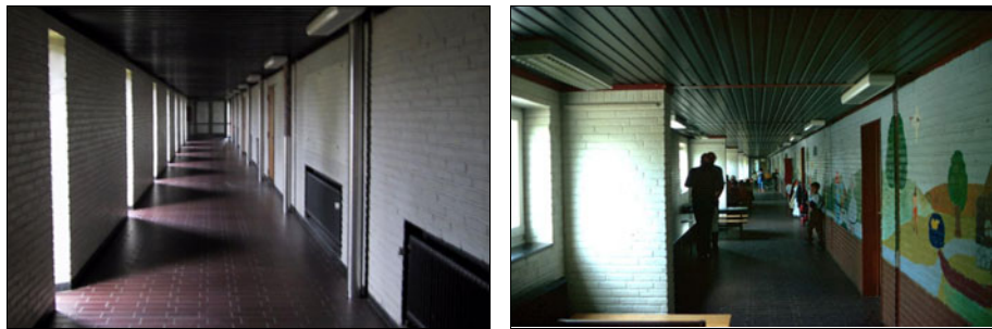
Figur 38. Tingbjerg skole. Gangareal med smalle lodrette vinduer til at markere gangforløbet (t.v.) samt gangareal i småbørnsfløj. På grund af de mørke gulve og lofter virker gangarealerne meget mørke, og kontrasten til de lyse klasserum bliver næsten for stor, lige når man træder ind.
