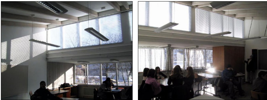
Figur 45. Billeder fra de to lokaler på Tingbjerg skole som er renoveret og har fået opsat persienner. Persienerne er lette at justere, og de giver mulighed for en mangfoldighed af lysindfald efter det aktuelle ønske og behov.
