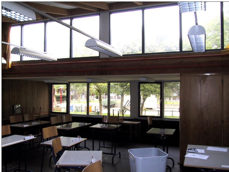
Figur 66. Den gamle almenbelysning bestod af i alt 12 armaturer med ældre, ikke dæmpbare, energikrævende lysstofrør.
