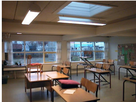
Figur 20. Egebjerg skole. Ovenlysenes placering forekommer noget tilfældig, og korresponderer ikke med behovet for supplerende lys i lokalerne. Desuden ses det også her, at belysningsarmaturer er placeret under ovenlysene, hvorved dagslyset reduceres unødigt.
