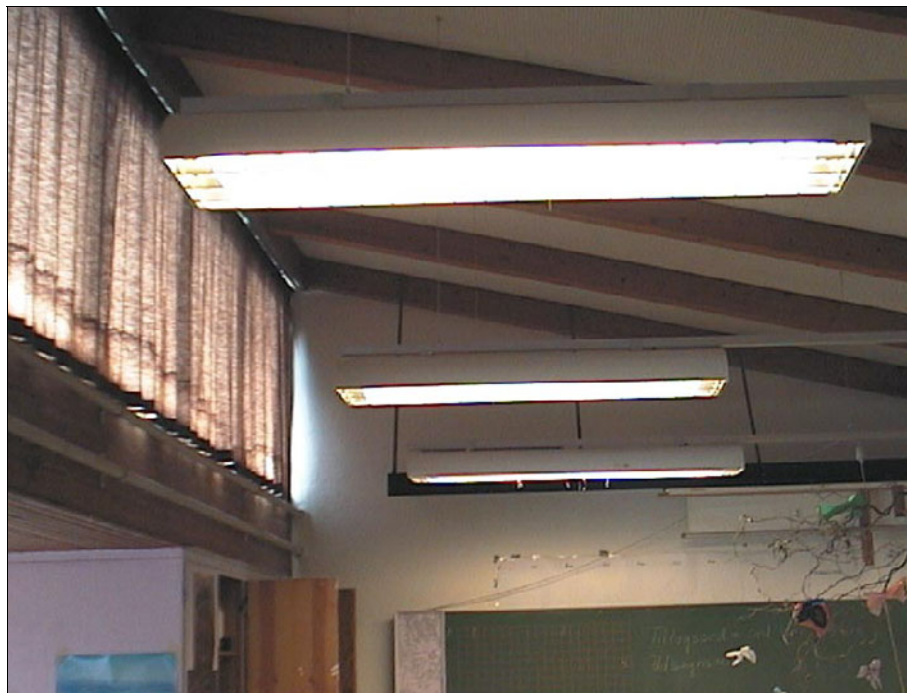
Figur 75. Eksisterende forhold. Nogle lokaler havde ingen afskærmning, mens solafskærmningen bestod af mørke gardiner, der var så uflexible, at de permanent var trukket for og udelukkede dagslyset, så kunstlyset måtte tændes.
