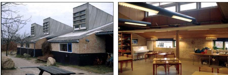
Figur 29. Stenvad skole. Hjemklasseområder med ensidigt dagslysfald fra dels et stort højtstående 'kvistvindue', dels nogle mindre udsigtsvinduer og en glasdør. På trods af det ret store vinduesareal forekommer dagslysniveauet utilstrækkeligt i flere områder af lokalet.
