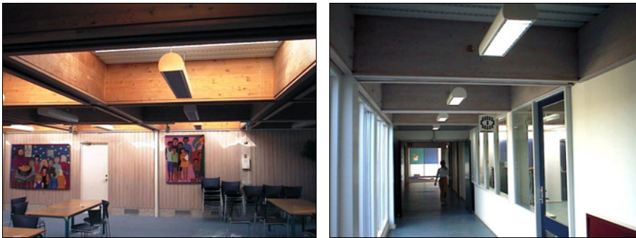
Figur 18. Stavns Holt skole. Ovenlys placeret uhensigtsmæssigt, efter skolens oprindelige udformning. Skaktvirkningen i ovenlysene forstærkes af de høje limtræsdragere, og dagslyset får en udpræget lodret retning med dårlig formgængivelse af rumlige objekter. I andre områder af skolen har man givet limtræsdragerne en hvidpigmenteret maling samt malet øvrige detaljer lysere, hvilket giver en blødere lysfordeling samt forbedrer det visuelle indtryk væsentligt.
