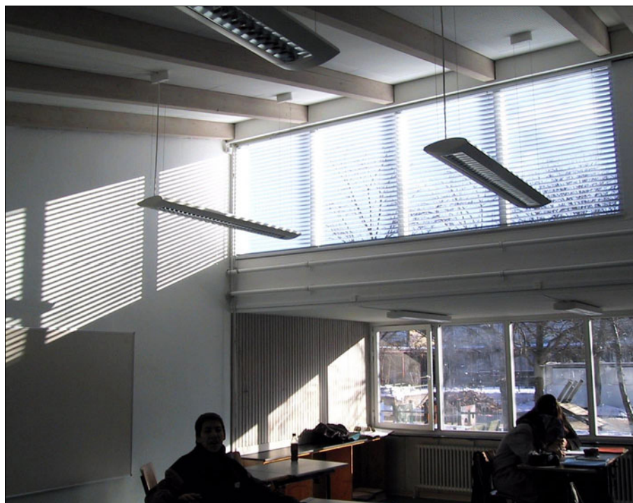
Figur 76. Afskærmningen af de højtstående vinduer i de to renoverede lokaler består af enkle persiener, som kan drejes eller trækkes helt op, alt efter behovet for dagslys.
