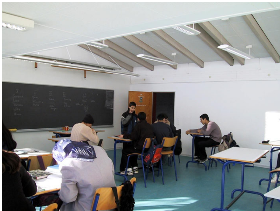
Figur 62. Lokale efter renoveringen. Indvendige vægge, loffelter og træpaneler er malet hvide, og loftbjælker har fået en hvid-pigmenteret overfladebehandling. Gulvet har fået en ny linoleumsbelægning, der virker mere livligere, selvom den kun er lidt lysere (højere en lidt højere lysreflektans).
