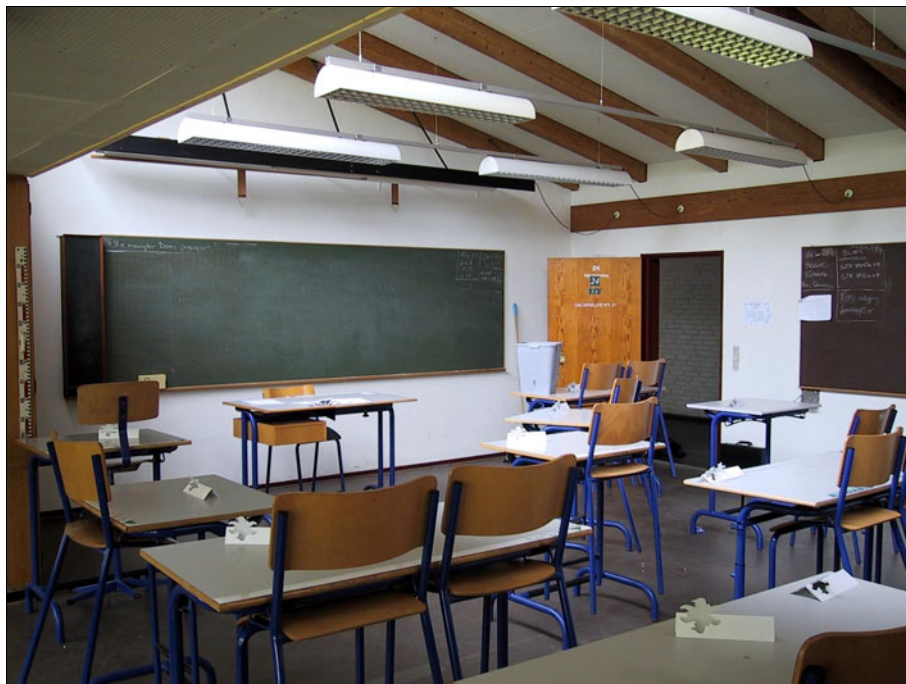
Figur 61. Klasselokale før renovering. Lokalet har hvide vægge, hvide loftsplader i den høje del og ubehandlede, grå gipsplader i den lave del. De lyse flader står i kontrast til det mørke gulv, de mørke træbjælker og træpaneler samt de mørke vinduesrammer og brystningsparti, se også figur 58.
