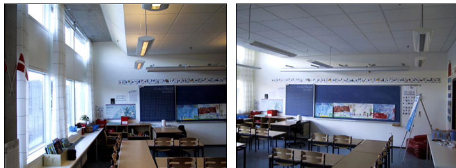
Figur 14. Hedegaardsskolen. Lyset kastes dybt ind i rummet fra de højtsiddende dagslysvinduer. Blænding fra himlen reduceres ved at de to vinduestyper er forsynet med uafhængige solafskærmninger.
