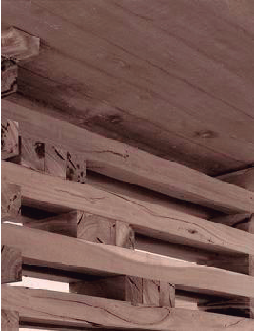
Imagen 174: Detalle de la escalera
