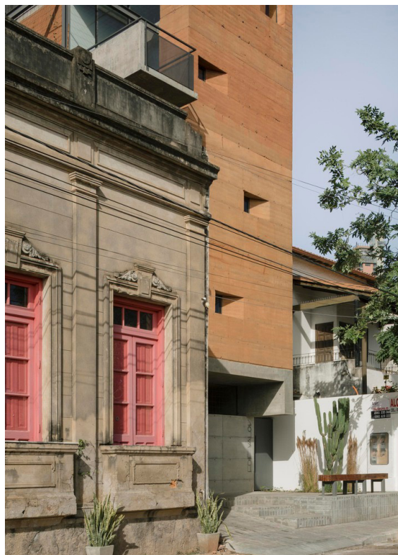
Imagen 15: Edificio Valois, José Cubilla, Asunción. Técnica tapial
