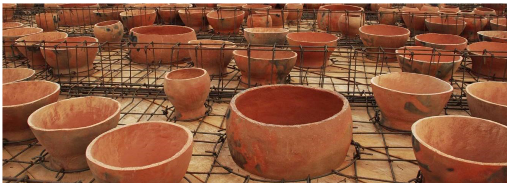
Imagen 153: Cerámicas en losa de Biblioteca de Gando
