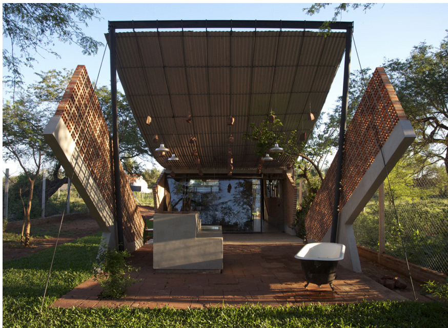
Nota. Tomado de: https://www.archdaily.cl/cl/02-62608/casa-hamaca-laboratorio-de-arquitectura
