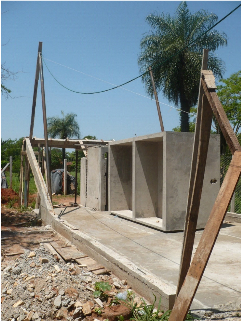
Imagen 54: Foto de obra de La casa hamaca
