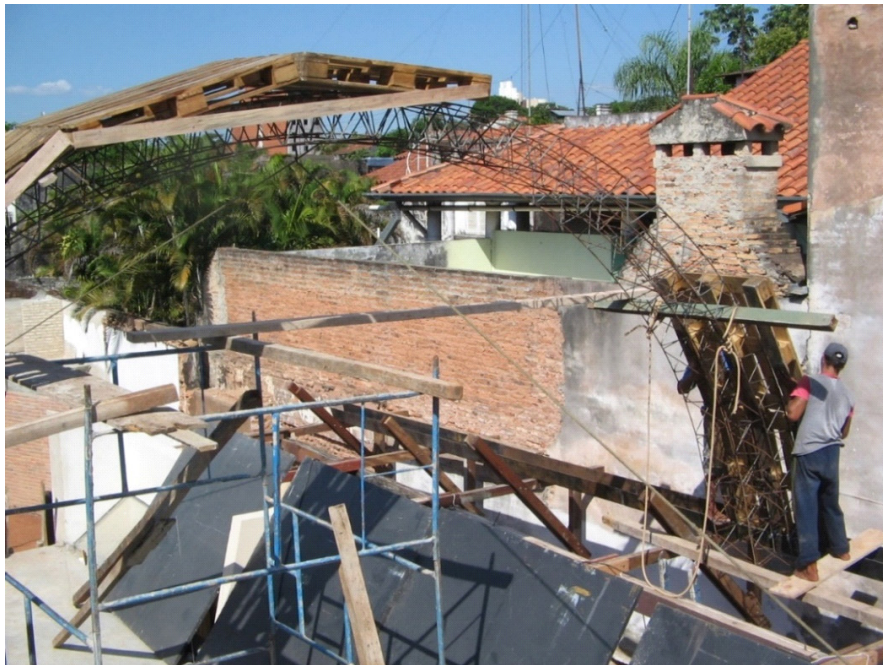
Imagen 42: Foto de obra de la casa Gertopán
