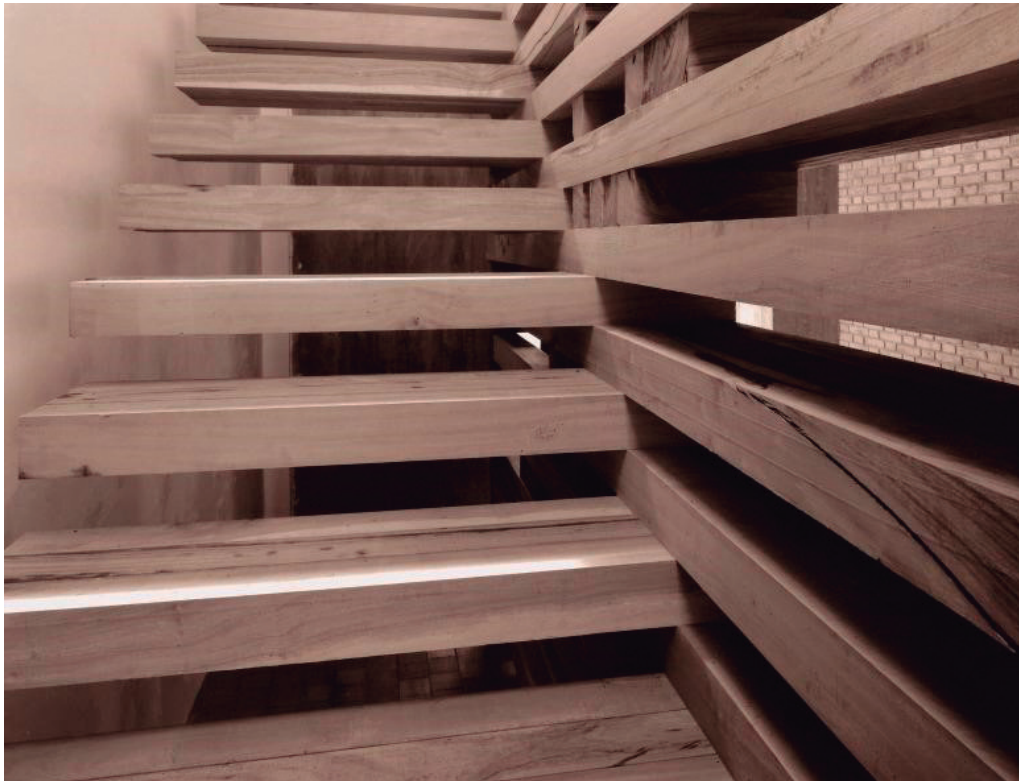
Imagen 176: Detalle de la escalera
