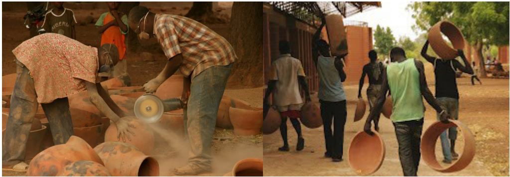
Imagen 150: Hombres de Gando cortando y cargando vasijas cortadas y verificando la resistencia de la bóveda.
