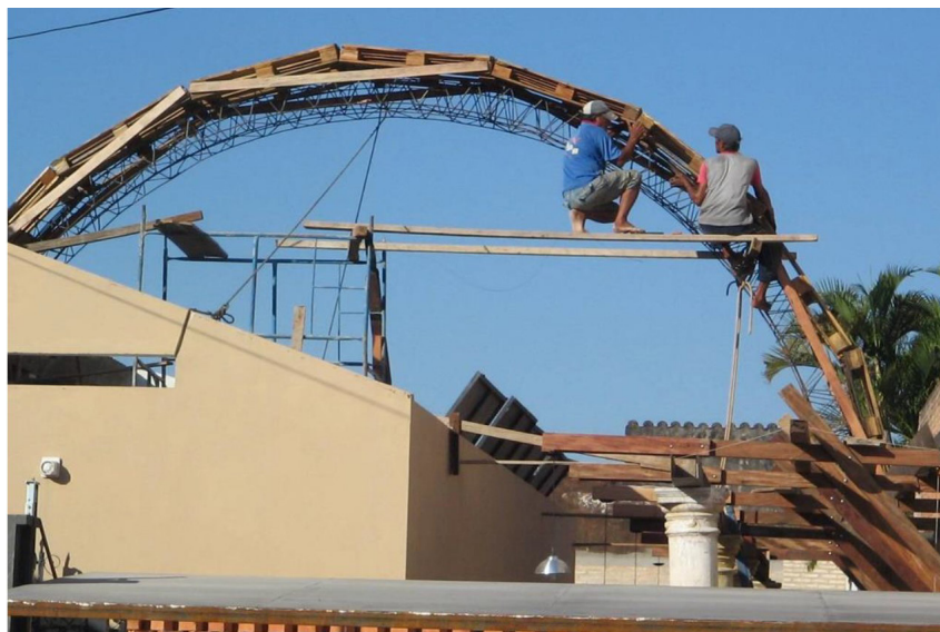
Imagen 39: Foto de obra de la vivienda Gertopán
