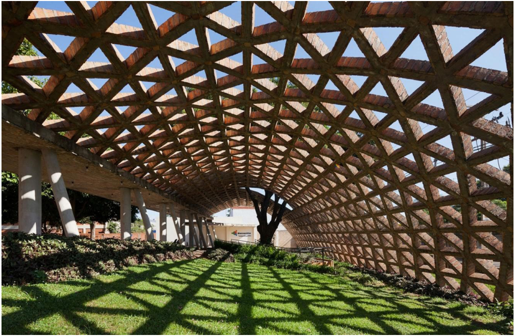
Imagen 85: Fundación Teletón, bóveda de acceso
