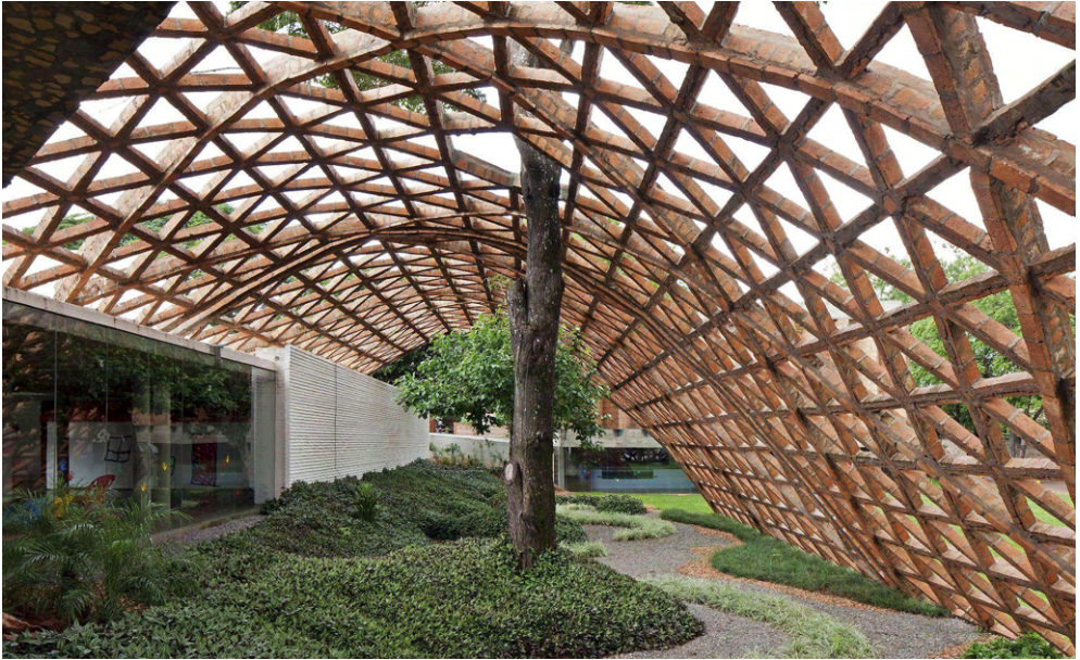
Imagen 84: Fundación Teletón, bóveda de acceso
