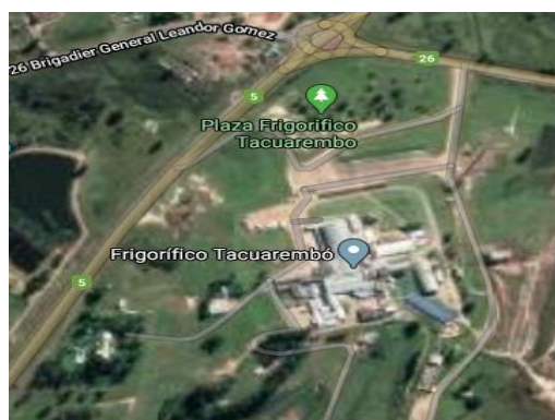
Figura 14. Imagen satelital de “Frigorífico Tacuarembó S.A”, Marfrig (Fuente: Google Maps).
