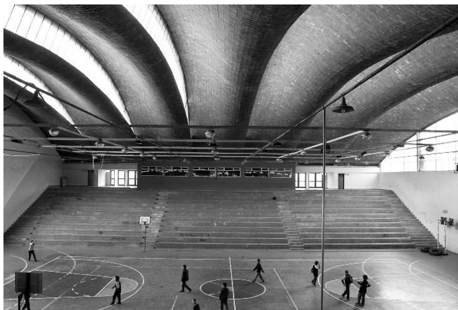
FIGURA 11. VISTA ACTUAL DEL INTERIOR DEL GIMNASIO DE DURAZNO.
