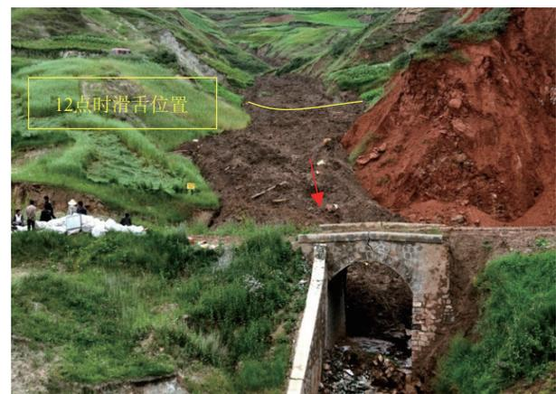
图 7 滑坡前舌及挤压变形的小桥
