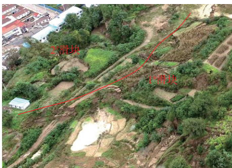
图 6 1#、2#滑块之间裂缝及相对错动
