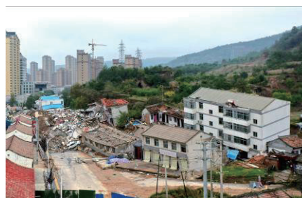
图 4 滑坡前缘破坏情况
