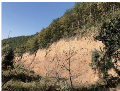
图 9 滑坡后壁直立陡坡照片
