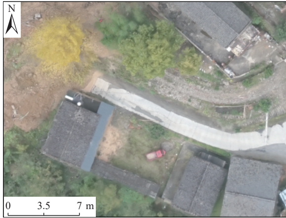
图 7 公路横向贯通裂缝
