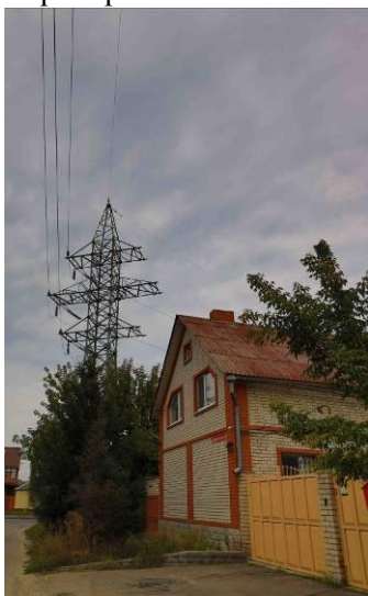
Рис.2. Жилой дом, расположенный вблизи одноцепной ЛЭП. 2
