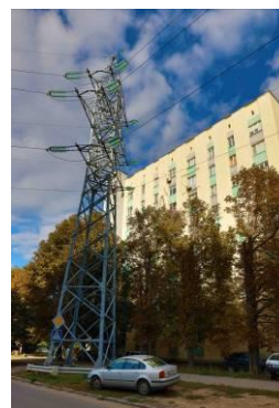
Рис.1. Жилой дом, расположенный вблизи двухцепной ЛЭП. 1
