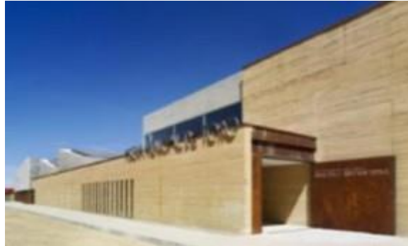
Figura 2. Entrada de acceso piscina cubierta, fuente:( vier arquitectos S.L.).
