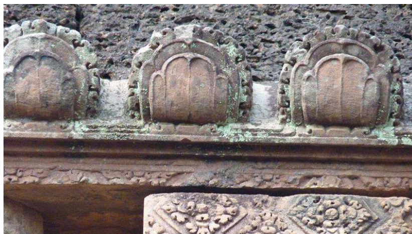
Fig. 9. Banteay Srei (Cambodge), détail d'une corniche dotée de pétales de fleurs de lotus, face exposée, lichens en arêtes et canaux d'écoulement entre pétales, oxydation manganique et cyanobactéries en larges surfaces (cl. B. Phalip).
