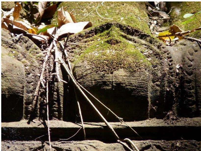
Fig. 10. Beng Mealea (Cambodge), détail d'une corniche dotée de pétales de fleurs de lotus bien conservés, lichens et mousses en arêtes et larges surfaces (cl. B. Phalip).
