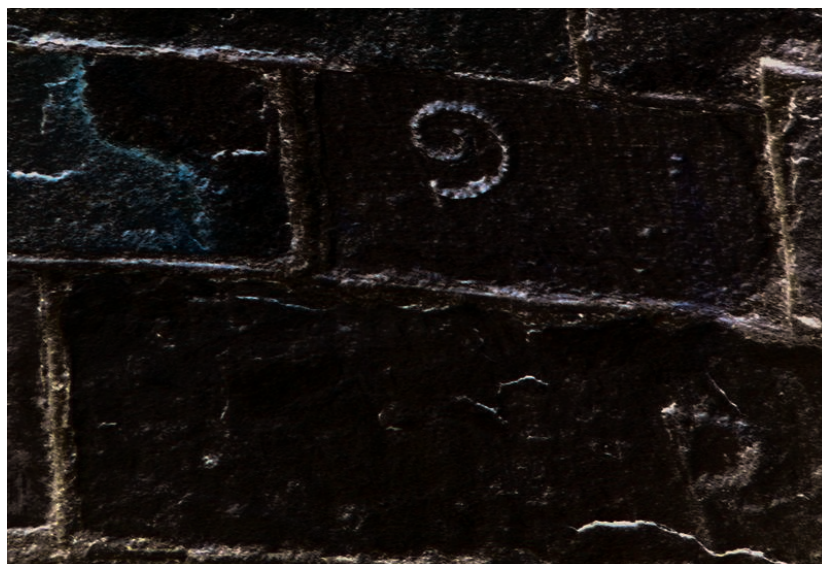
Fig. 9. Beaulieu-sur-Dordogne (Corrèze), chevet du XII e siècle : carreau en grès taillé « dans le lit » muni d'un signe lapidaire (G oncial) et layé (sillons faiblement conservés) ; les autres carreaux sont « en délit » et desquamés (cl. D. Morel).
