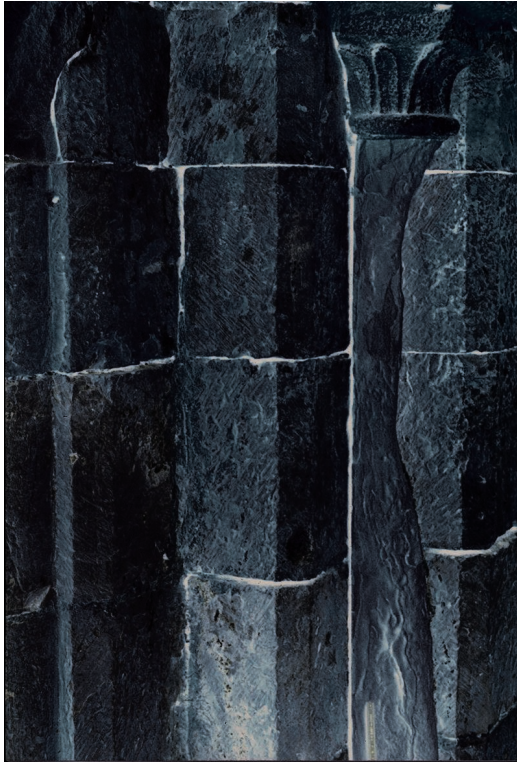
Fig. 4. Desquamation des grès micacés de l'église d'Estivals, Corrèze. Par comparaison, on notera la bonne tenue du chapiteau en calcaire oolithique (cl. M.-F. André).
