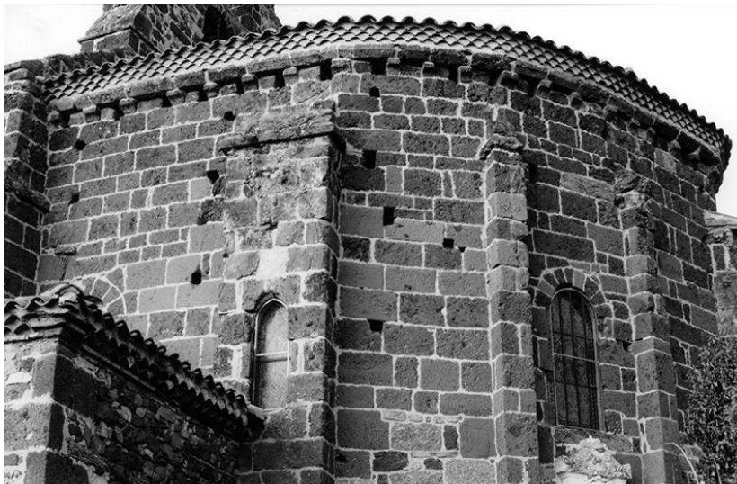
Fig. 8. Mazeyrat-Aurouze (Haute-Loire), chevet du XII e siècle, trous de boulins non traversants et suite de trous à la naissance de la voûte sous la corniche de modillons. Les tufs sont particulièrement touchés au sommet des contreforts (cl. B. Phalip).
