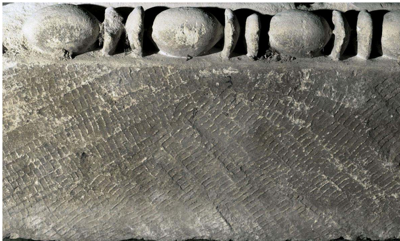
Fig. 6. Souvigny (Allier), prieurale saints-Pierre-et-Paul, barrière liturgique du troisième quart du XII e siècle, traces brettées sur le lit de pose d'une des plaques (cl. P. Dubois).
