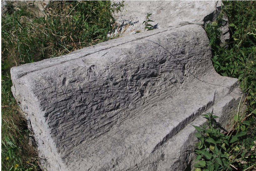
Fig.1. Puy-de-Dôme, temple de Mercure (63), taille antique au marteau-taillant et au ciseau large (cl. B. Phalip).
