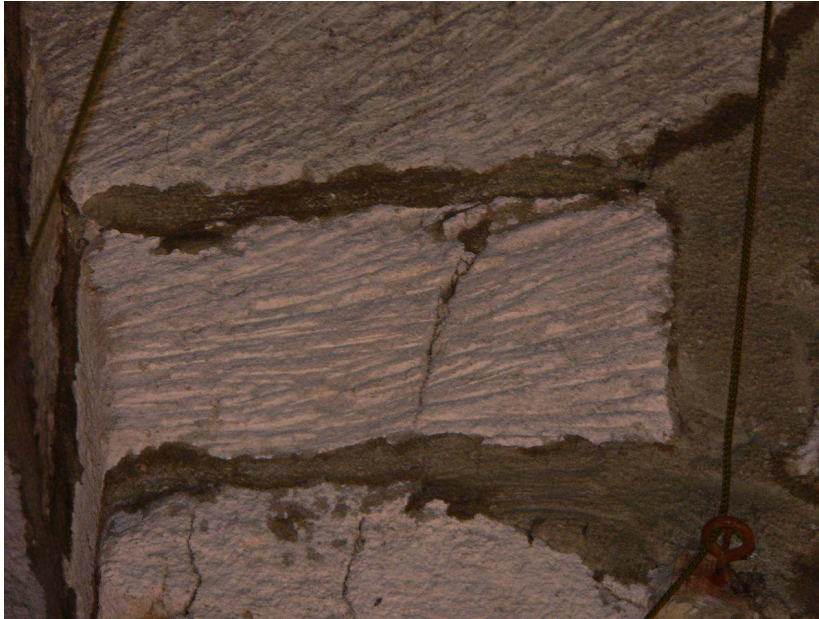
Fig. 3. Église de Saint-Germain-Laprade (43), taille désordonnée de la fin du X e siècle au marteau-taillant (cl. D. Morel).
