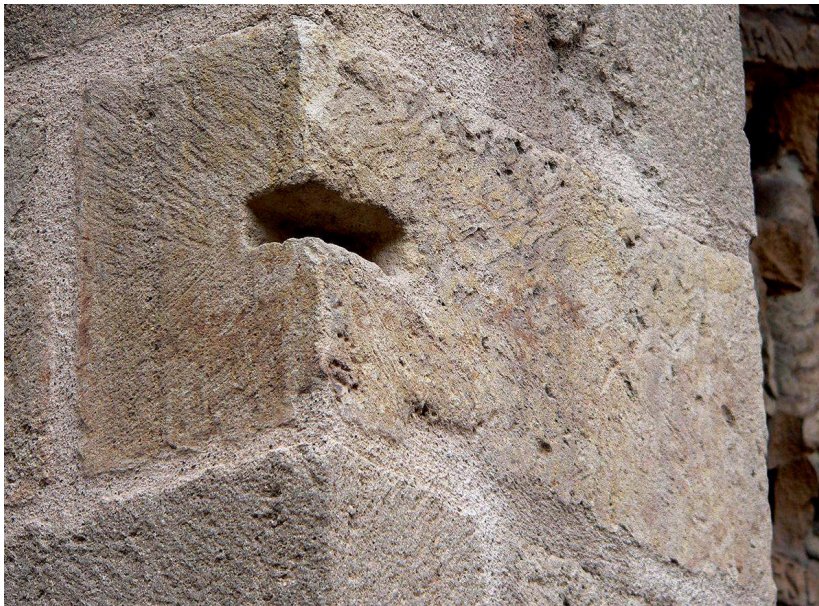
Fig. 4. Église Notre-Dame-du-Port (Clermont-Ferrand, 63), face de pose antique (à droite) d'un remploi retaillé dans le second tiers du XII e siècle (à gauche), marteau-taillant, taille en feuille de fougère en deux larges bandeaux (cl. D. Morel).
