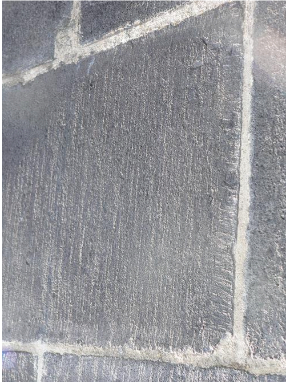
Fig. 5. Clermont-Ferrand, cathédrale, parties hautes du chevet, fin XIII e siècle, marteau-taillant, taille « peignée » en quatre ou cinq bandeaux se chevauchant et liseré périmétrique (cl. B. Phalip).
