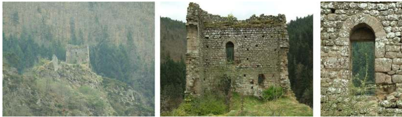
Fig. 4. Vestiges de Chabrespine-Saint-Martial à Grazac - De gauche à droite : vue générale, face interne de la tour, détail de la porte du 1 er étage (cl. M. Bizri).
