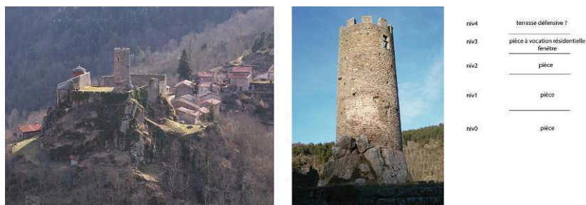
Fig. 7. Tour circulaire - Chalencon à Saint-Pal-en-Chalencon. De gauche à droite : vue générale, tour et fonctions des niveaux (DAO et cl. M. Bizri).
