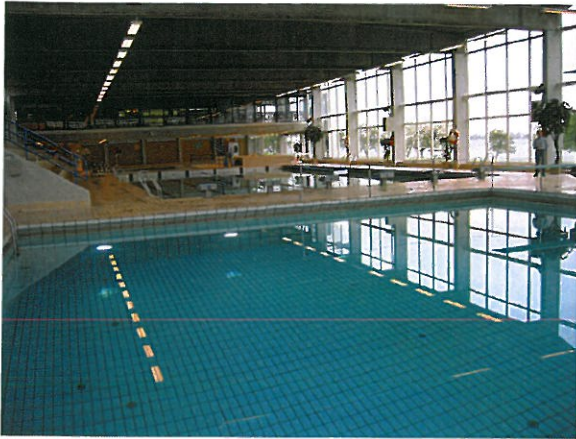
Figure 1: An inside view of Korsør Svømmehal.
