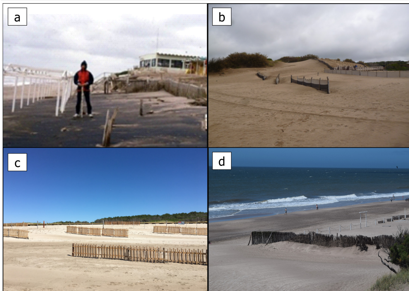
Figura 3. Enquinchados y vallas como defensa de espaldones. a) Alfár (1990; General Pueyrredón); b) Cariló (2019, Pinamar); c) Costa Esmeralda (2020, Partido de la Costa); d) Villa Gesell (1996).
