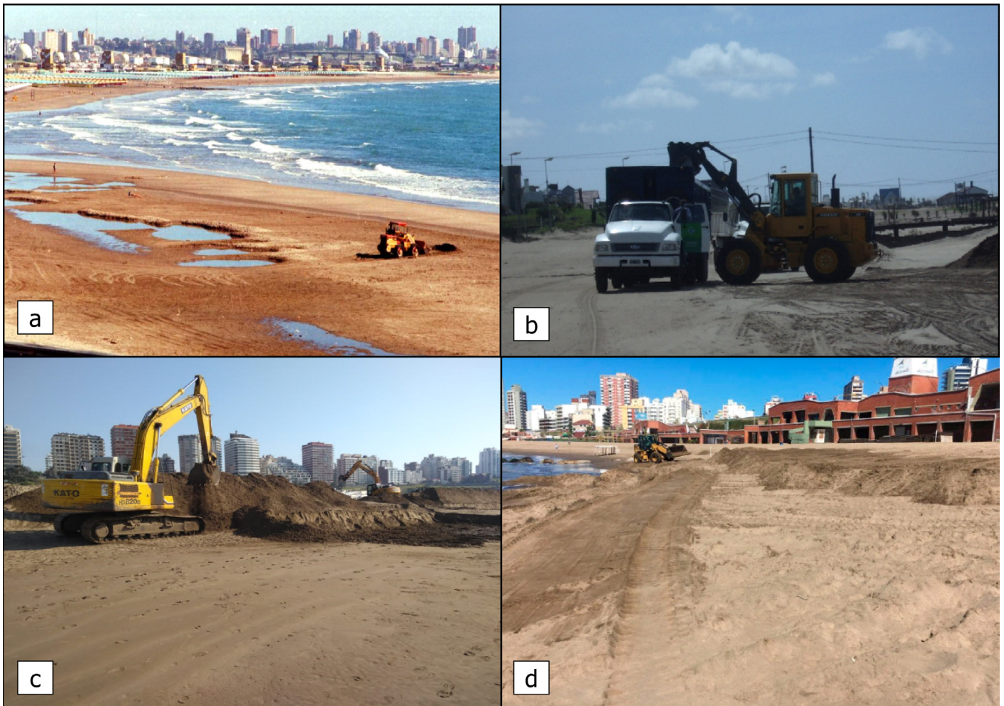
Figura 8. a) Movimiento de arena en Punta Mogotes previo a la temporada estival (1990); b) Limpieza de avenida costanera en Pinamar; c) Movimiento de arena en Playa Grande (agosto de 2018, General Pueyrredon); d) Movimiento de arena en balneario de playa La Perla (setiembre 2018, General Pueyrredon).
