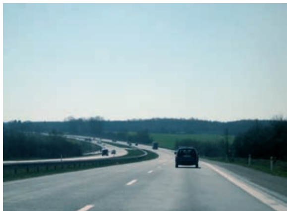
Åbnet: 1990 (Rønnede – Udby) Tværprofil: 26 profil med 3 m midterrabat. (4-sporet)
