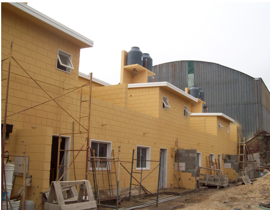
Imagen 2. Conjunto habitacional en proceso de construcción, Villa Corina, Avellaneda
