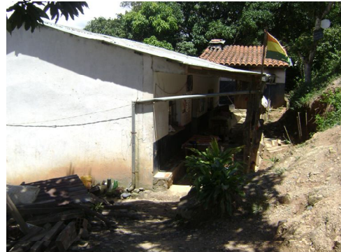
Fig. 6: Habitación principal con galería para usos múltiples de una vivienda.
