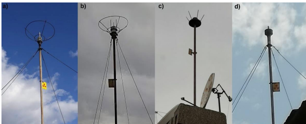
Slika 1: Četiri tipa gromobrana sa radioaktivnim izvorom koji su ugrađivani na teritoriji Republike Srbije: (a) ^{60}\text{Co} , (b), (c), (d) ^{152,154}\text{Eu} (izvor: Laboratorija Zaštita, INN „Vinča“)
