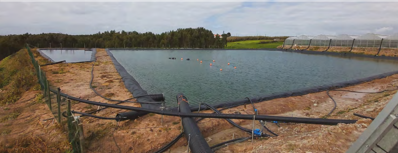
Figura 2 - Charcas impermeabilizadas: grande (ao centro), para recolha da precipitação caída sobre as estufas; pequena (à esquerda), para recolha da drenagem do sistema fechado de cultivo em substrato. A mistura controlada destas águas é a única fonte para a rega nesta empresa, desde 2018 (HortoMaria Lda, A-dos-Cunhados, foto da empresa).
