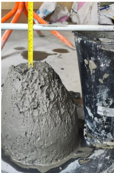
Figura 8 Ensayo de asentamiento para hormigón patrón.
