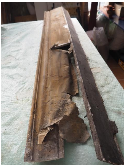
Figura 42 - Tábua de união do retábulo com o arco cruzeiro.
