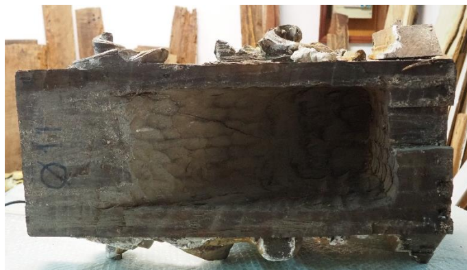
Figura 12 - Verso de mísula, marcas de ferramentas da produção.
