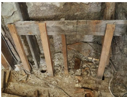
Figura 62 - Estrutura de suporte da mesa de altar.
