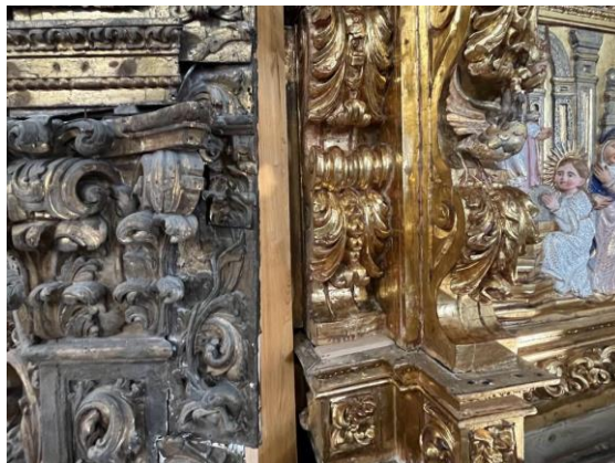
Figura 88 - Ligação do retábulo com o arco cruzeiro.
