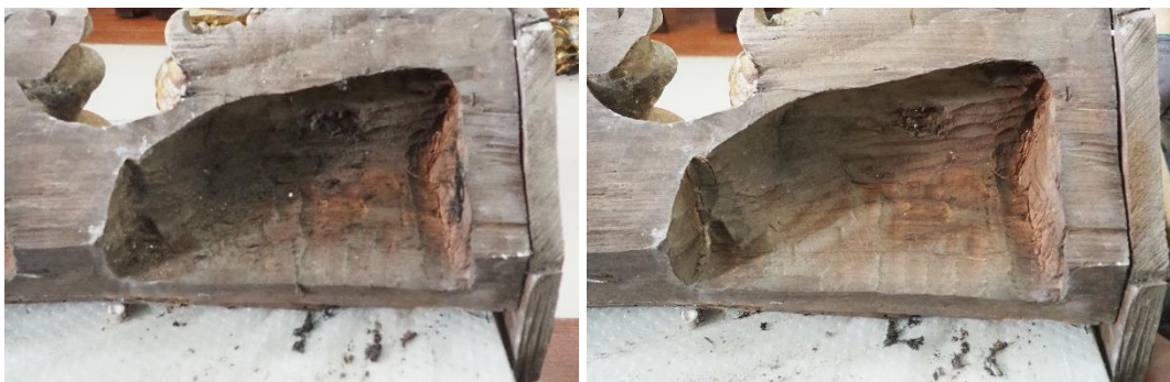
Figura 74 - Antes e depois da limpeza mecânica do tardo.
