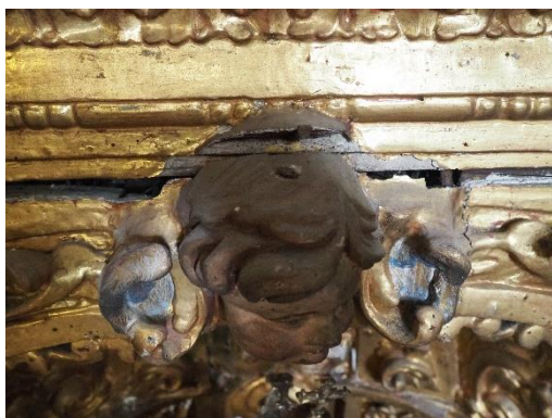
Figura 58 – Fratura causada por oxidação de elemento metálico.
