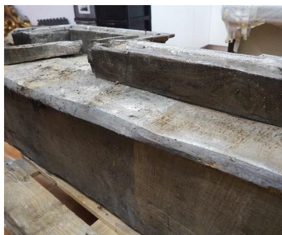
Figura 246 - Verso do entablamento depois da intervenção.
