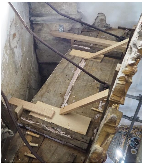
Figura 244 - Topo da sanefa após a intervenção.
