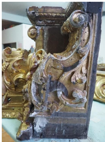
Figura 43 - Mísula com entalhes removidos.
