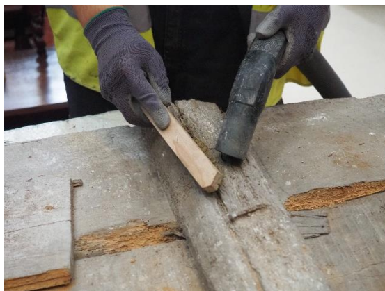
Figura 73 - Aspiração tardez após desmontagem.
