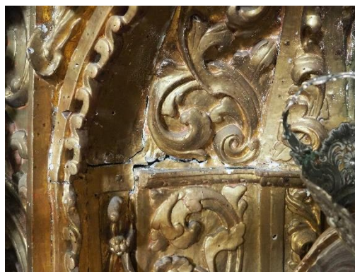
Figura 59 – Afastamentos no interior do nicho.
