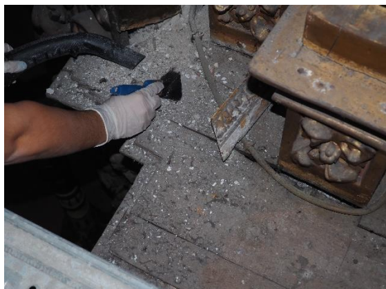
Figura 72 - Aspiração antes da desmontagem.
