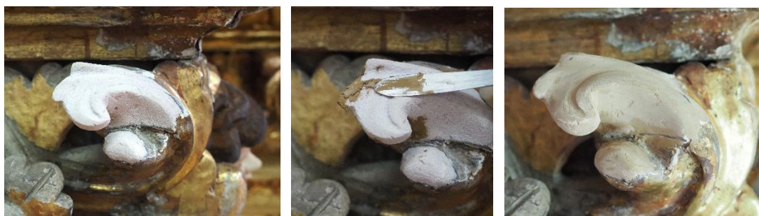
Figura 84 - Aplicação de Modostuc® sobre Balsite®.
