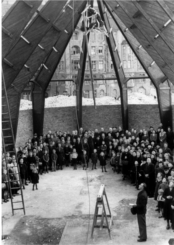
Figure 5: Erection of the roof timbers in the ‘emergency church’ constructed in Berlin-Rummelsburg in 1948. Source and Permission: Das Evangelische Werk für Diakonie und Entwicklung, Berlin, 8.1.3 Notkirchen 2046, 1948–1949, ADW/ZBB 2046.
