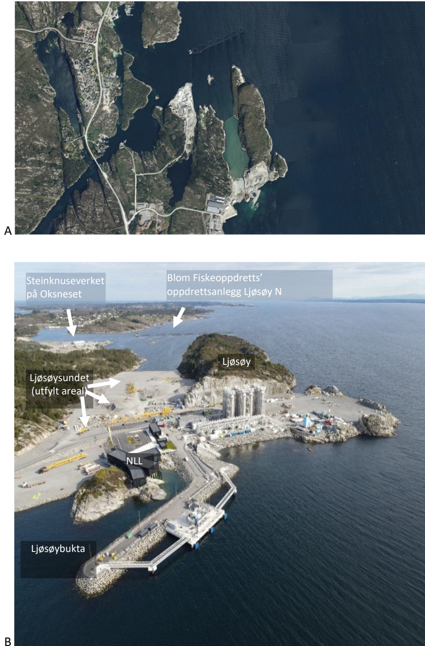
Figur 1. Oversiktsbilder over Northern Lights' landanlegg (NLL) i Øygarden kommune og utfyllingstiltaket i tidlig fase (A) og etter at arbeidet var gjennomført (B). Tiltaket medførte at Ljøsøysundet, som opprinnelig var nesten 1 km langt, nå er for en stor del utfylt. Oppdrettsmerdene til Blom Fiskeoppdrett (Ljøsøy N) ses her lokalisert rett nord av Ljøsøy. På nabetomten til NLL ser man steinknuseverket på Oksneset. (Foto B: Richard Wilson/Equinor ASA).
