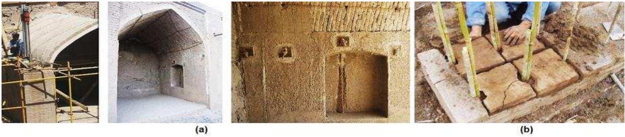
Şekil 14. (a) Hurma halatlarının yerleştirilmesi için kerpiç duvarın delinmesi ve halatların taşıyıcı duvarların içinden geçişi (b) Duvarların içine yerleştirilmiş bambu örnek modelleri (Rouhi, 2017).
