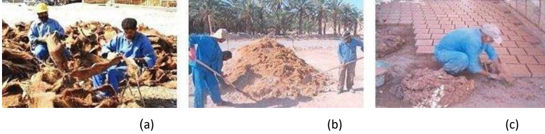
Şekil 13. (a)(b)(c) Bam Kalesi'nin atölyesinde palmye lifleri ile güçlendirilmiş kerpiç üretim süreci (Mokhtari ve Shad, 2008)
