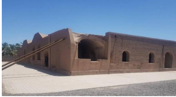
Şekil 10. Hanasayi Fabrikasının Depremden Sonra Duvarlarının Güçlendirilmesi (Hasani, 2020)
