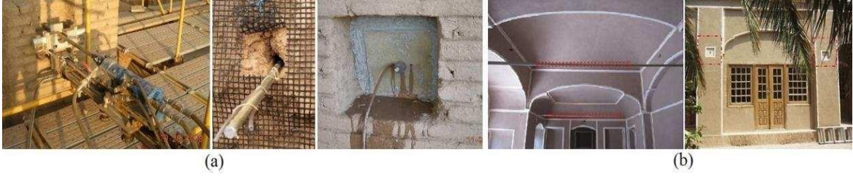
Şekil 12. (a) Arg-i-Bam 1 No'lu Kule'de bağlama ve ankraj işlemi ve (b) Bam Kalesi'ndeki Sistani Evi'nde bağlantı çubuklarının bağlanması ve ankraj ile duvar-çatının iç takviyesi (Aveta, Marino ve Rouhi, 2017).
