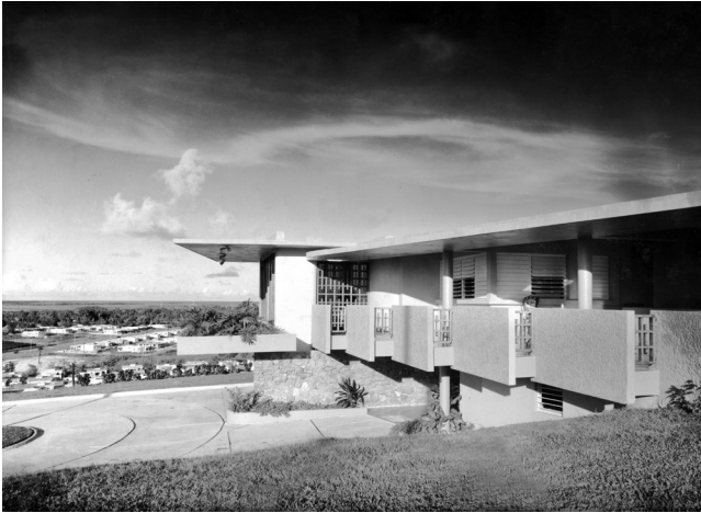
06 Henry Klumb, Casa Fullana, San Juan, Puerto Rico, 1953-1955, exterior view, 1955. © Photograph: Alexandre Georges, Henry Klumb Collection, Archivo de Arquitectura y Construcción Universidad de Puerto Rico (AACUPR).
