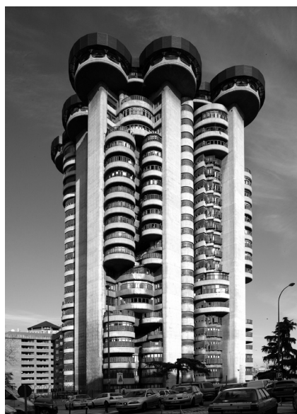
01 Francisco Javier Sáenz de Oíza, Torres Blancas , Madrid, Spain, 1958-1972. Exterior view. © Pedro Ibáñez, 2011, Archivo del Servicio Histórico de la Fundación Arquitectura COAM.
