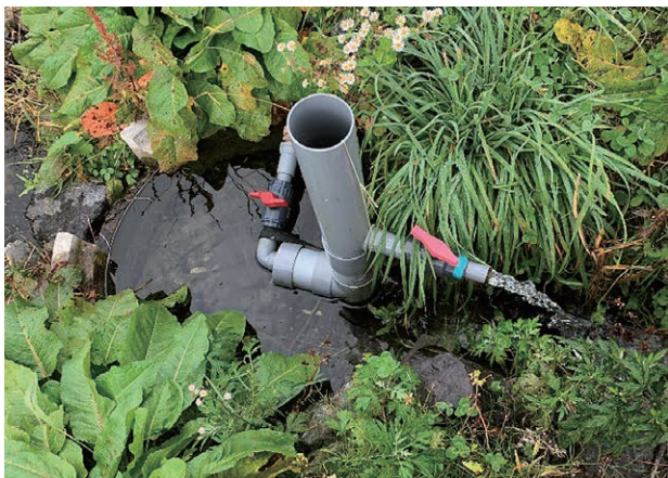
写真4 湧水導水部の状況 (2022年5月)
