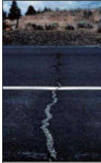
Figura 13: Mecanismo característico de deformación fija en la trayectoria de la rueda externa
