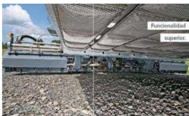
Figura 3: Reciclado en T° caliente In- situ
