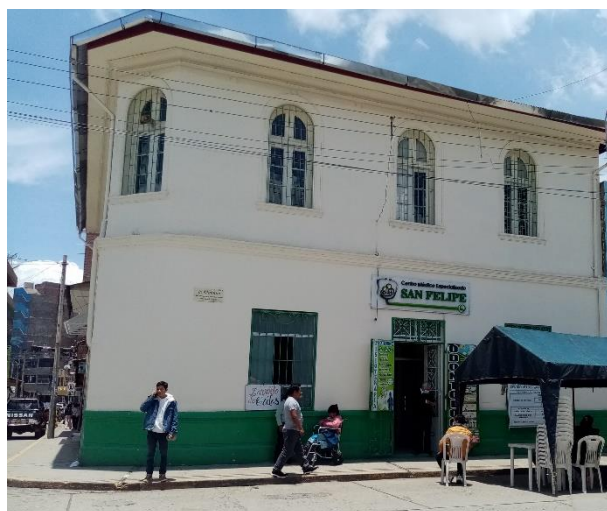
Edificación de adobe en área de intervención
