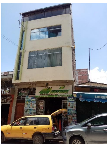
Edificación de ladrillo en área de intervención
