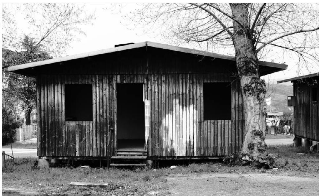
Fig. 1. Prefabbricato a Conza della Campania (Avellino) (foto di E. Di Guglielmo).
