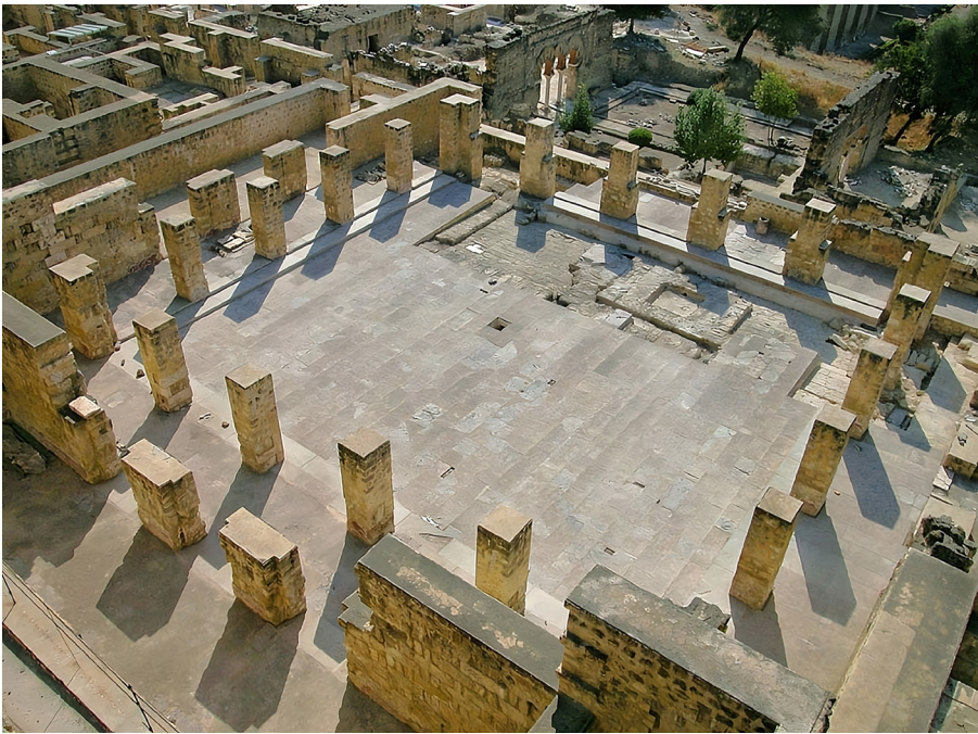
1 »Patio de los Pilares« at the beginning of the conservation work. (Photo: Conjunto Arqueológico de Medina Azahara, Manuel Pijuán)
