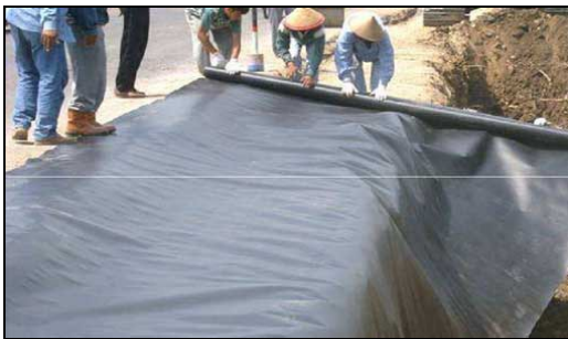
Gambar 4. Contoh pemasangan Geomembran
