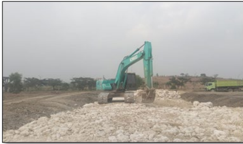
Gambar 3. Pemasangan batu kapur untuk proyek jalan
